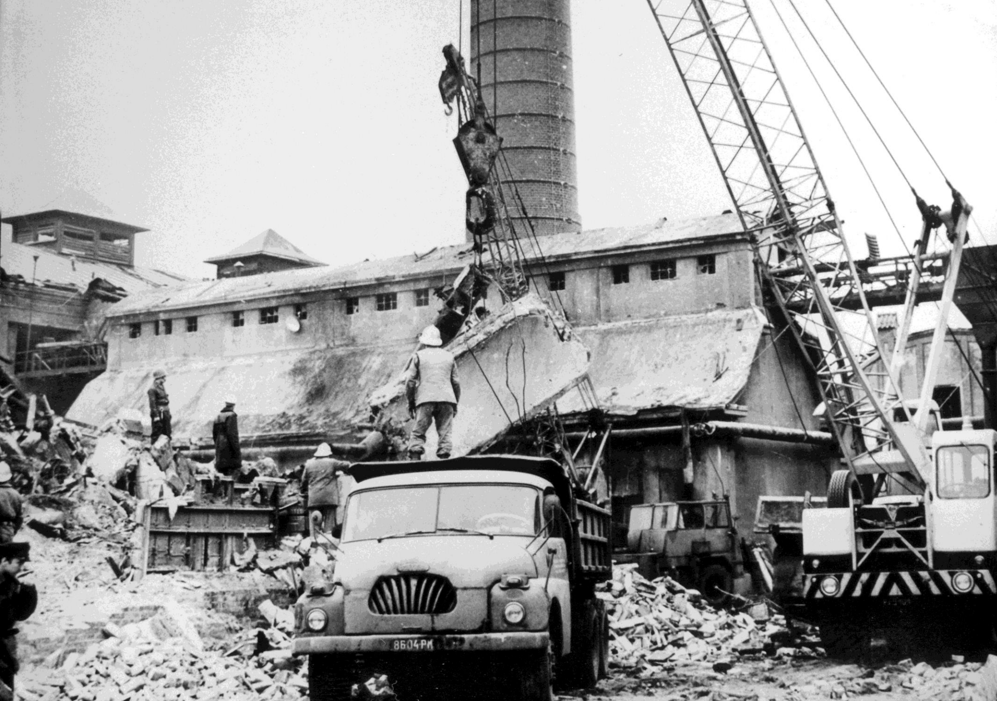
Rozbieranie ściany południowej, za którą ukazał się silos na opał stojący tuż za dekstryniarnią
