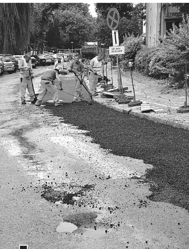
W deszczowy dzień, 11 lipca, ul. Osiedlową wypełniano warstwami masy bitumicznej fot. Piotr P. Ruszkowski
