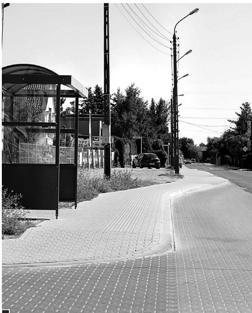
Zrealizowana inwestycja chodnika na ul. Sobieskiego
