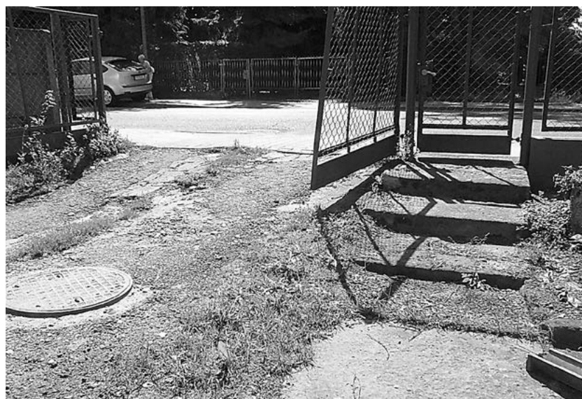
Jedną z przyczyn zalewania posesji przy ul. Ks. Streicha 27 – położenie poniżej poziomu drogi. Przy dużych opadach woda przelewa się przez chodnik i nachylnym podłożem wpływa na podwórze. Zalany plac za domem zamienia się w jezioro, przez które trudno przedostać się do garaży i ogrodów fot. Hanna Siatka
