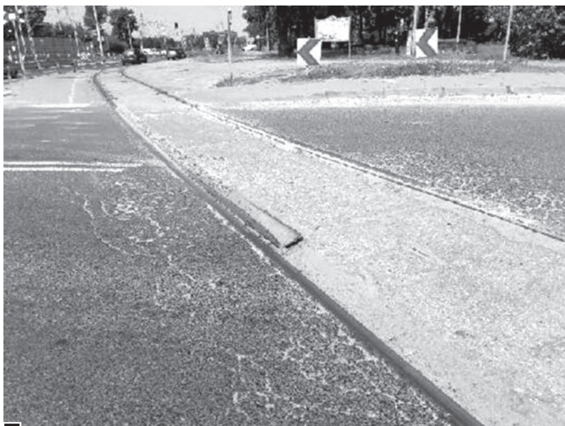
Ostre, metalowe, wystające kątowniki – pułapka nie tylko dla samochodów
