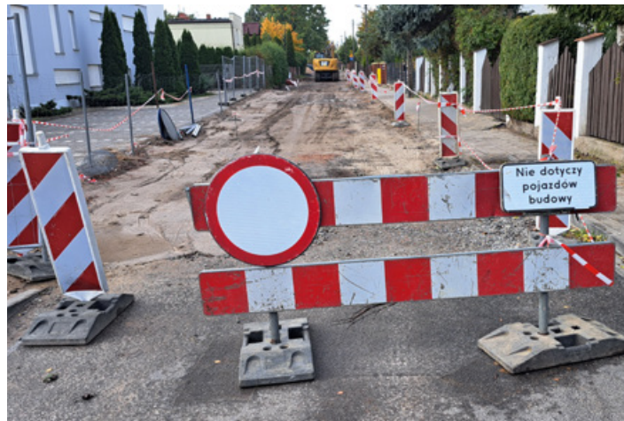
Rozpoczęto budowę odcinka ul. Miodowej fot. Paweł Wolniewicz
