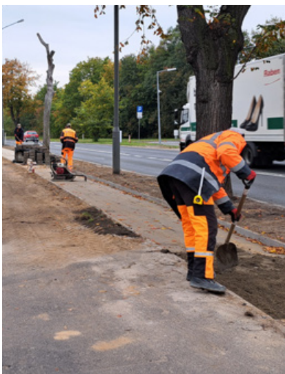
Prace remontowe polegały na wymianie nawierzchni odcinka chodnika w ul. Armii Poznań fot. Paweł Wolniewicz
