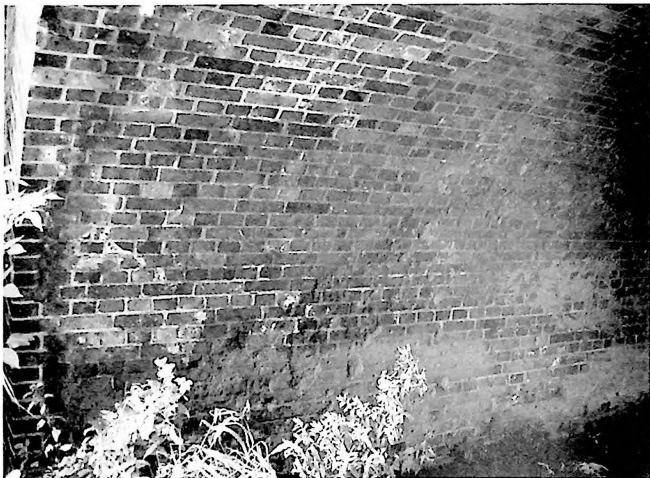
Na ścianach wewnątrz tunelu po dziś dzień widoczne są ślady eksplozji z 23 stycznia 1945 roku. 2006 r. (Z.A.)
