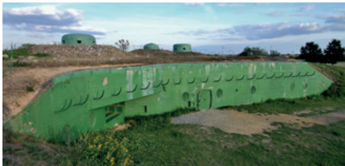
Schronów, propagandowo nazwanych Panzerwerk, powstało w sumie około stu. Pz.W. 717 z Grupy Warownej Scharnhorst zbudowano w latach 1938-1939. Funkcjonuje w nim całoroczna trasa turystyczna w ramach Muzeum Fortyfikacji i Nietoperzy znajdującego się w Pniewie. Na zdjęciu elewacja tylna schronu fot. Przemysław Maćkowiak
