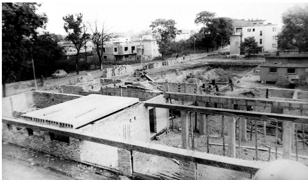
Widok ze starej szkoły na plac budowy przy ul. Dąbrowskiego – 1985 r.
