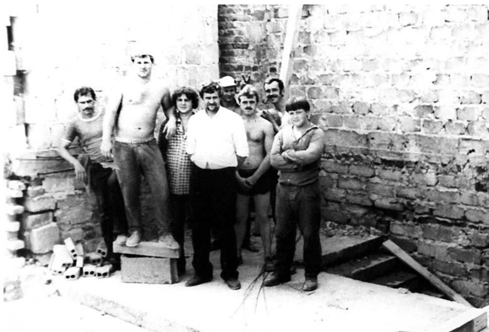
Brygada budowlańców na placu budowy nowej szkoły podstawowej w Luboniu (SP3) – 1985 r.
