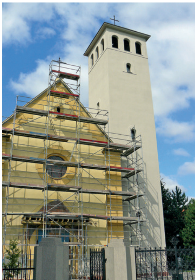
Wieża świątyni zyskała świeży blask. Ustawiono rusztowania i rozpoczęto renowację elewacji frontowej fot. Paweł Wolniewicz
