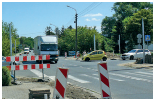
W celu usprawnienia ruchu pieszego oraz kołowego skrzyżowanie będzie wyposażone m.in. w nowy sterownik sygnalizacji świetlnej fot. Paweł Wolniewicz
