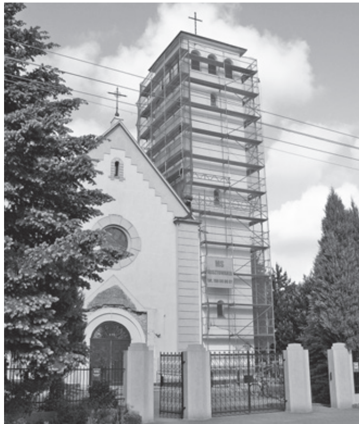
Wokół wieży świątyni ustawiono rusztowania i rozpoczęto renowację elewacji fot. Paweł Wolniewicz
