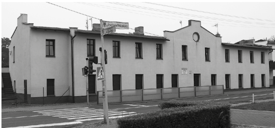
Zabytkowy budynek, przy ul. Powstańców Wielkopolskich 19, w którym mieściła się Wyższa Szkoła im. Haliny – dzisiaj prywatny budynek mieszkalny fot. Paweł Wolniewicz
