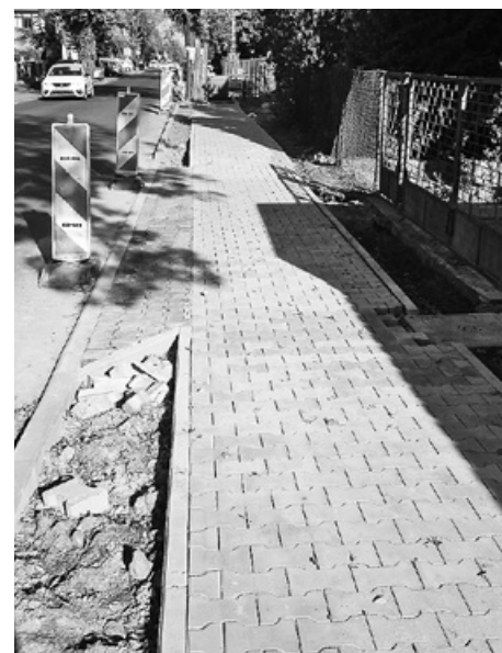
Budowa nowego chodnika na ul. Poniatowskiego fot. Hanna Siatka
