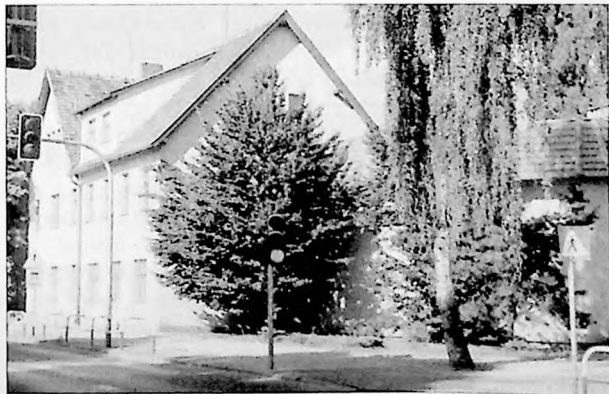
Ryc. 36. Po trzykrotnej rozbudowie szkoły nr 2, przeprowadzonych w latach 1961, 1993 i 1996, dawny budynek szkolny pełni dziś rolę pomocniczą (1999 r.).
