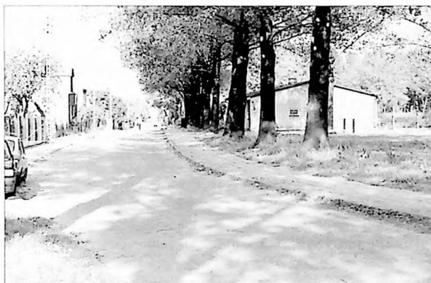
Ryc. 49. Ulica Niezlomnych w Luboniu – w tym miejscu we wrześniu 1942 r. więźniowie zaprzęgnięci do walca drogowego, ugniatali rozsypany żużel. Był to początek budowy obozu żabikowskiego.
