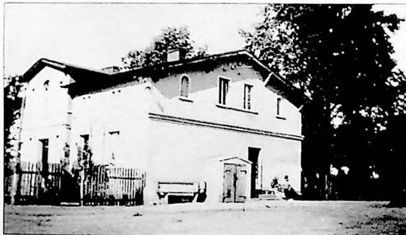
Ryc. 23. Dom mieszkalny rodziny Mizerków – widok od strony podwórza (ok. 1938 r.)
