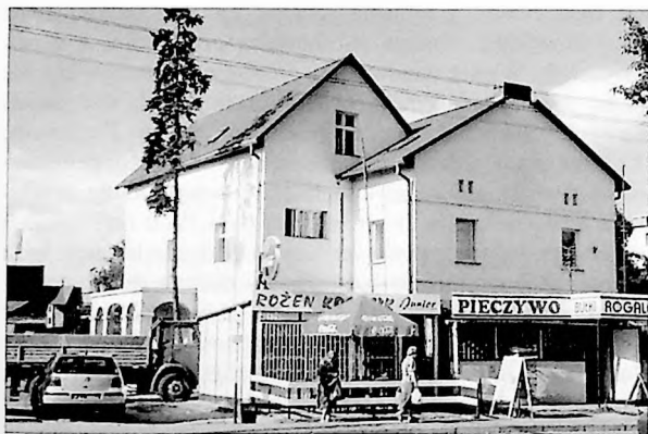
Ryc. 8. Dom mieszkalny przy ul. Żabikowskiej zbudowany ok. 1873 r. na miejscu dawnych średnio-wiecznych siedzib soltysów żabikowskich. Odbudowany przez Andrzeja Maternę. Widok od północnego-wschodu (1999 r.).
