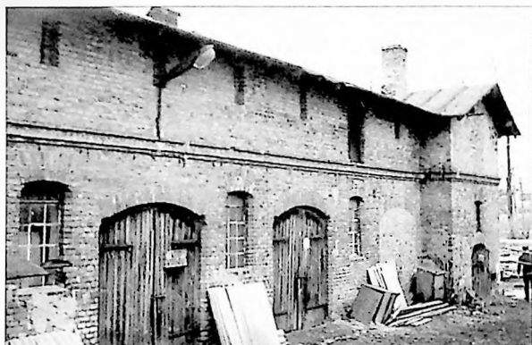
Ryc. 98. Obora ze stajnią – widok na ścianę północną od strony podwórza (1997 r.)
