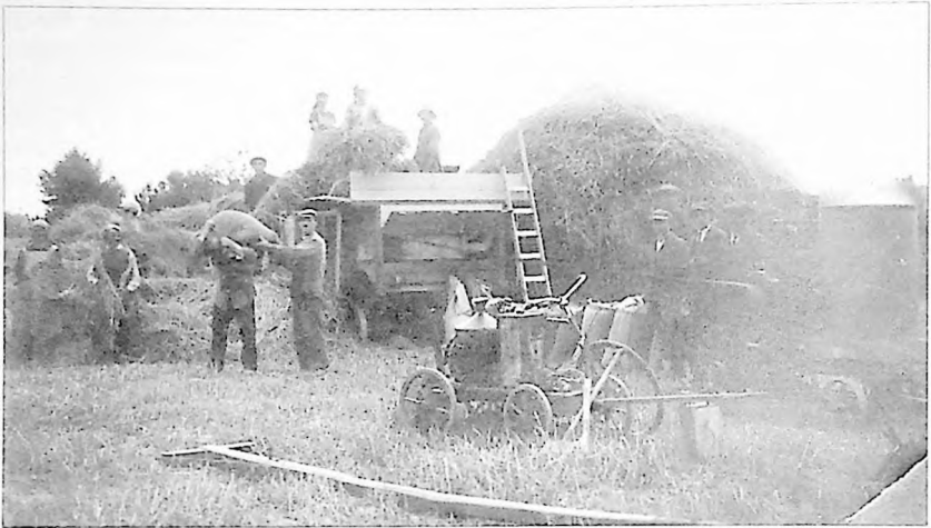
Ryc. 37. Ostatnie przedwojenne omloty. Spółka „Motor”, działająca w Żabikowie, posiadająca młocarnię i silnik spalinowy, wykonywała prace omlotowe na polach gospodarzy żabikowskich. Z usług tej firmy korzystał też folwark uniwersytecki.
