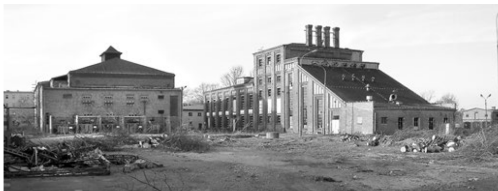
Widok na niektóre budowle po WPPZ (stan – listopad 2005 r.). Z prawej syropiarnia z 1925 r., z lewej gorzelnia (pierwotnie kotłownia i elektrownia z 1914 r. fot. Piotr P. Ruszkowski
