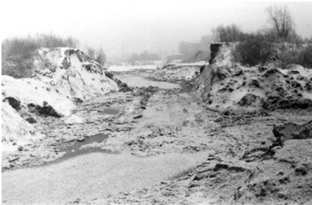
Specjalnie przerwany spychaczami wał odstożników, by zalegający cuchnący szlam spłynął do pobliskiego Strumienia Junikowskiego, co wyraźnie widać z powodu niewielkich opadów śniegu, kontrastujących ze spływającą breją (luty 1991 r.) fot. Piotr P. Ruszkowski
