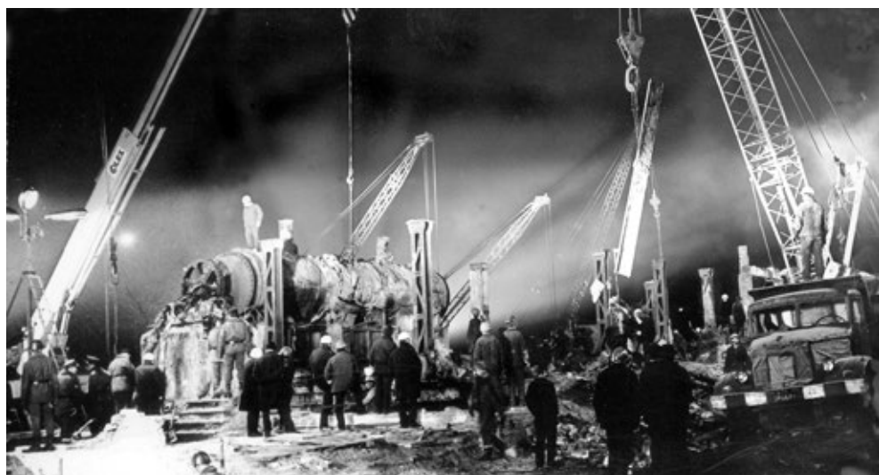
Nocne przygotowywanie masywnego urządzenia do jego demontażu z udziałem czterech dźwigów fot. Danuta Matuszewska, arch. „WL”
