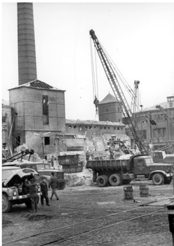
Końcowy widok ogólny w fotoreportażu z akcji ratunkowo-porządkowej dekstryniarni: w oczekiwaniu na załadunek kierowcy ciężarówek wykorzystują czas na dokonanie przeglądów, zajrzenie pod maskę wozu, usunięcie drobnych usterek, uzupełnienie płynu w chłodnicy? fot. Danuta Matuszewska, arch. „WL”
