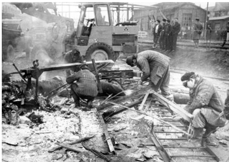
Spawacze tną palnikami acetylenowymi stalowe elementy fot. Kazimierz Przychodzki arch. „WL”
