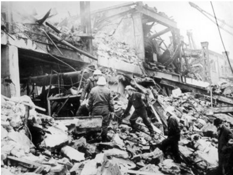
Kolejnym etapem akcji jest penetracja wnętrza w poszukiwaniu poszkodowanych pracowników nocnej zmiany i sukcesywne usuwanie wszystkiego, co stoi na przeszkodzie. Działania ratowników w tym nieprzewidywalnym środowisku są obarczone dużym ryzykiem i bardzo niebezpieczne. Na szczęście, nic nie wiadomo o ewentualnych ofiarach wśród ratowników. Na zdjęciu dobrze widoczna wewnętrzna, stalowa konstrukcja nadziemnych kondygnacji dekstryniarni fot. arch. „WL”
