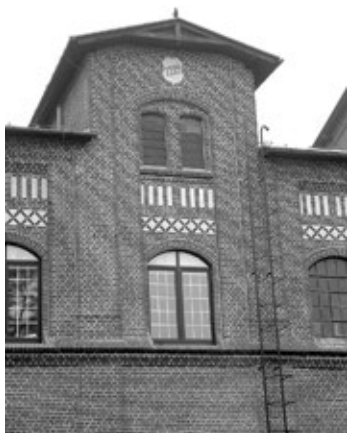
Najciekawszy architektonicznie fragment zabudowań krochmalni pszennej z 1924 r., który zakupiła Hydrobudowa. Podczas renowacji dodatkowo pomalowano fugi ceglane na biało, co „nie podobało się” wojewódzkiemu konserwatorowi zabytków – stan z listopada 2005 r. fot. Piotr P. Ruszkowski
