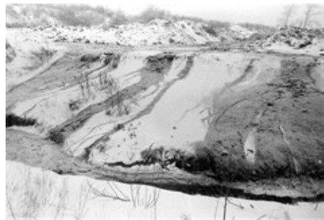
Specjalnie przerwany spychaczami wał odstożników, by zalegający cuchnący szlam spłynął do pobliskiego Strumienia Junikowskiego, co wyraźnie widać z powodu niewielkich opadów śniegu, kontrastujących ze spływającą breją (luty 1991 r.) fot. Piotr P. Ruszkowski
