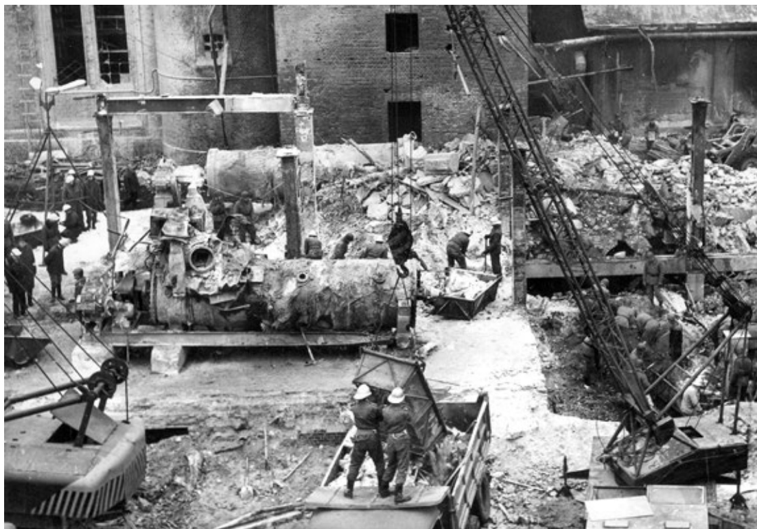
Panorama przyziemia wykonana z budynku administracyjnego WPPZ-ów. Ekipy strażaków i żołnierzy pracują równocześnie na całym obszarze byłej dekstryniarni. Jedni do skrzyń łopatami ładują gruz, inni kontrolują jego wysypywanie na wywrotki. Naprzemiennie wzdłuż byłej zachodniej ściany budynku ustawione dźwigi z wywrotkami. Nie ma już sterzących kikutów ścian szczytowych. Pozostały wielkie walcowe urządzenia, posadowione poziomo na masywnych fundamentach fot. Danuta Matuszewska, arch. „WL”
