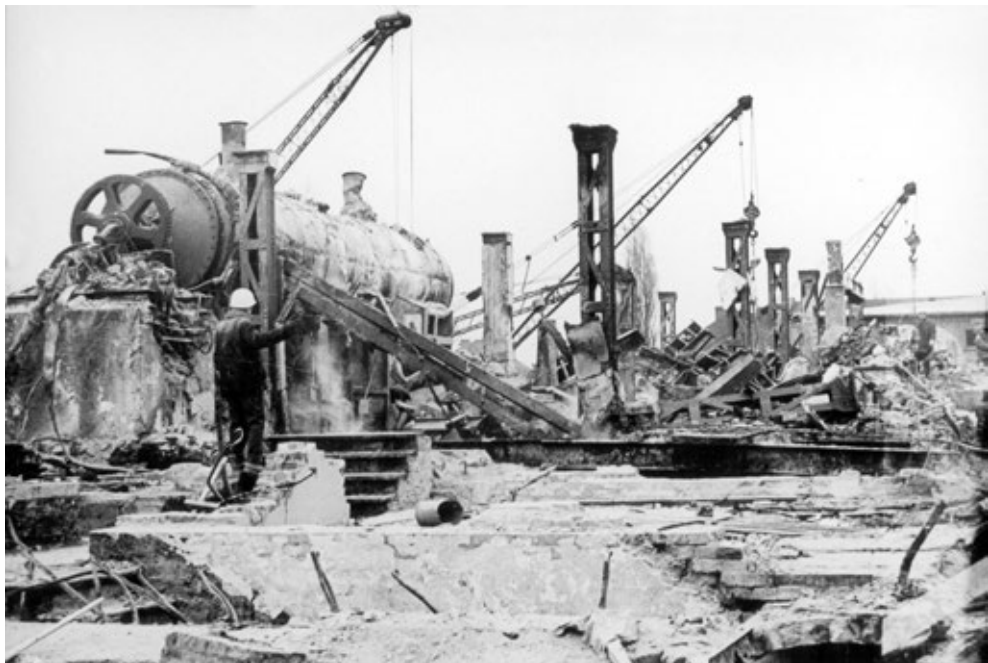
Widok z poziomu gruntu od stron południowo-wschodniego narożnika byłego budynku. Na tle nieba widoczne ramiona dźwigów pracujących po przeciwnej stronie byłej dekstryniarni fot. arch. „WL”
