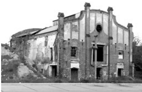
Wycierkownia – zabytek, który „przeszkadzał” nowym właścicielom od początku (stan z maja 2023 r.) fot. Piotr Ruszkowski
