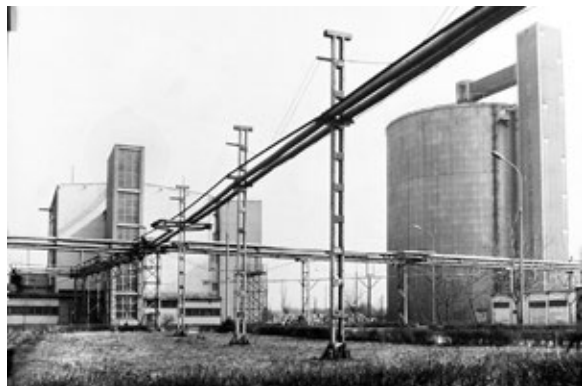
Kompleks nowej dekstryniarni wybudowanej w rok po tragedii w 1973 r. bliżej Warty w bezpieczniejszym miejscu (z lewej) – widziany od strony zakładu z instalacją dostarczającą ciepło tak potrzebne przy produkcji. Z prawej charakterystyczny silos (magazyn krochmalu) – wieloletnia dominanta pejzażu Lubonia fot. arch. „WL”
