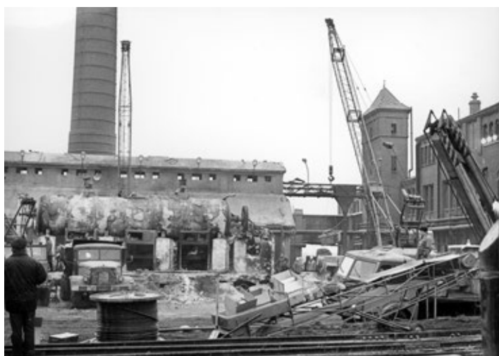
Widok na byłą dekstryniarnię od zachodniej strony. Równoległe z porządkiem terenu południowego, na pierwszym planie, przygotowane kable do naprawy uszkodzonej w wybuchu zakładowej trakcji elektrycznej fot. Danuta Matuszewska, arch. „WL”
