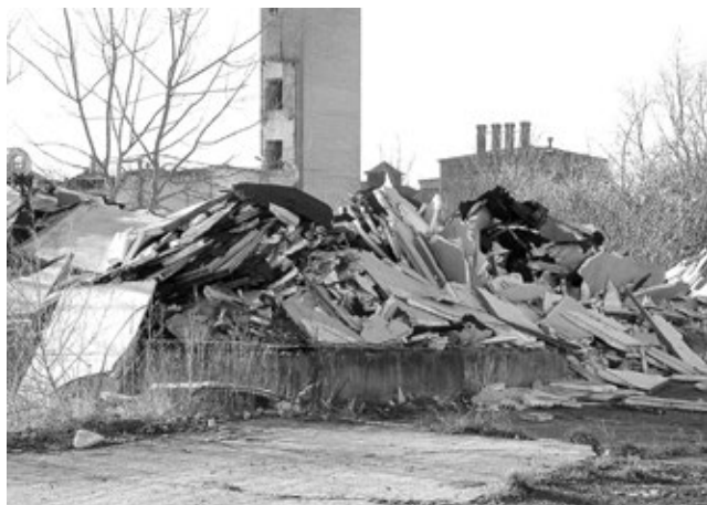
Po rozebraniu konstrukcji ze stalowych kształtowników, po dekstrynie pozostały hałdy styropianu potłuczonego szkła i gruzu żelbetowego, stoją jedynie jeszcze murowane łączniki komunikacyjne stan ze stycznia 2005 r. fot. Piotr P. Ruszkowski, arch. „WL”
