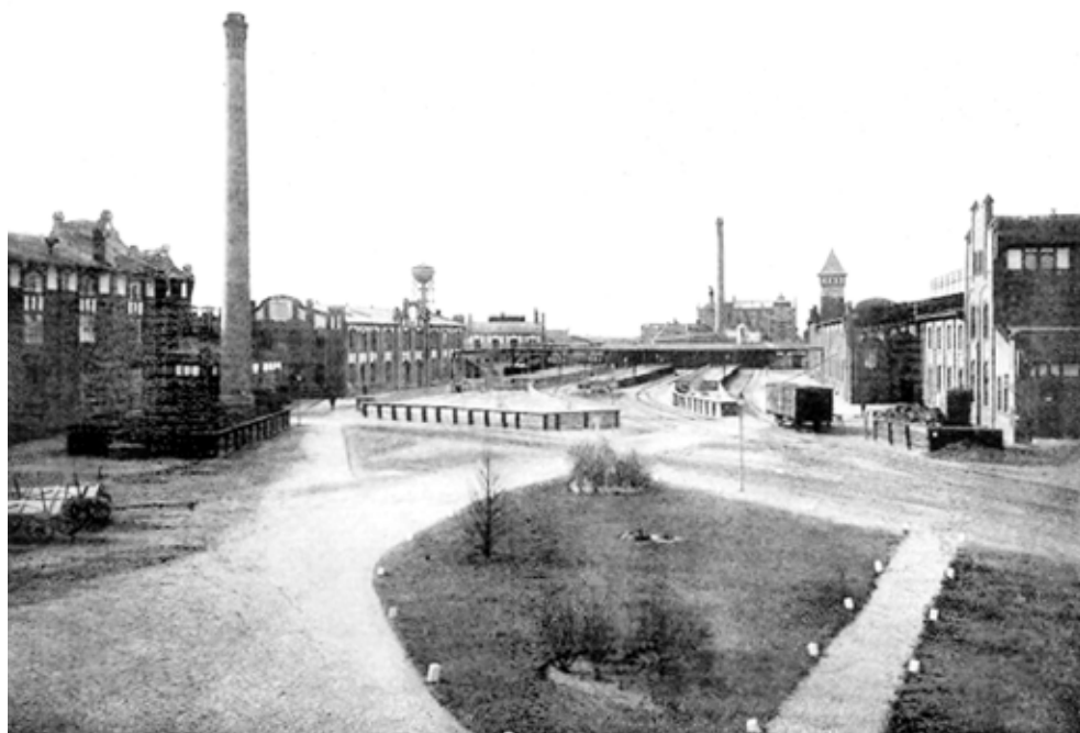
Widok na podwórze zakładów Koehlmann'a. Po lewej dekstryniarnia, po prawej dzisiejszy budynek Armii Poznań 49 b przebudowany później na typową bryłę prostopadłościanu, pozbawiony architektonicznego, pierwotnego stylu
