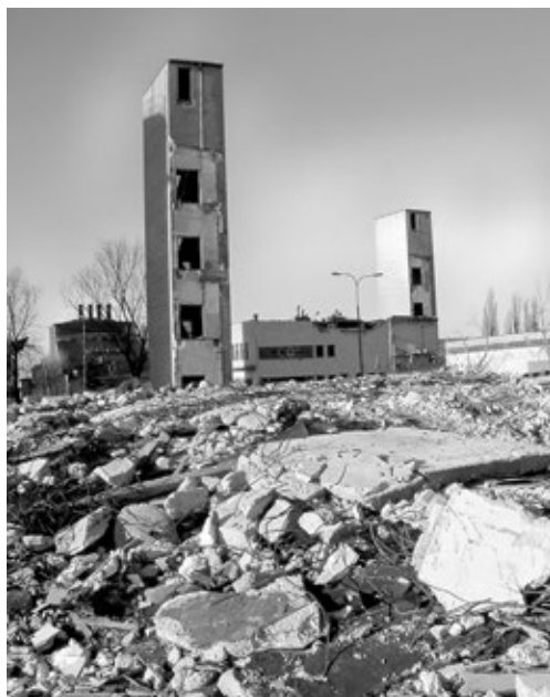
Po rozebraniu konstrukcji ze stalowych kształtowników, po dekstrynie pozostały hałdy styropianu potłuczonego szkła i gruzu żelbetowego, stoją jedynie jeszcze murowane łączniki komunikacyjne stan ze stycznia 2005 r. fot. Piotr P. Ruszkowski, arch. „WL”
