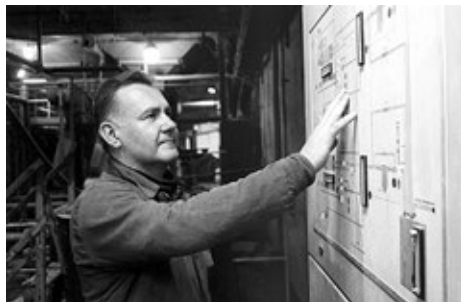
Zasadnicza część procesu technologicznego była zautomatyzowana fot. Przemysław Maćkowiak
