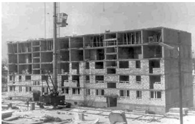
Budowa bloków dla pracowników Zakładów Ziemniaczanych w Spółdzielni Mieszkaniowej „Lubonianka” przy ul. Żabikowskiej 62 G-K w latach 60. XX w.
