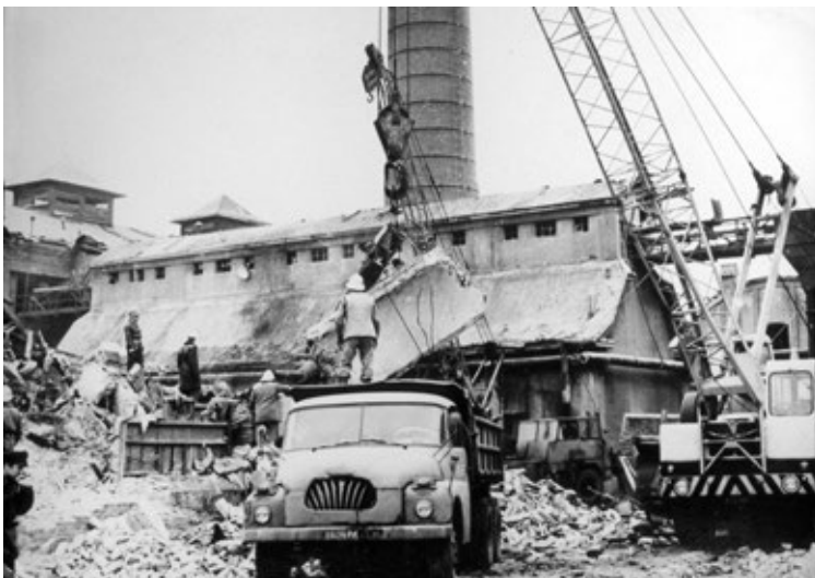
Na tym zdjęciu widzimy kończenie rozbiórki szczytowej ściany południowej, za którą ukazały się silosy węglowe dla sąsiadującej kotłowni (późniejszej gorzelni) fot. arch. „WL”
