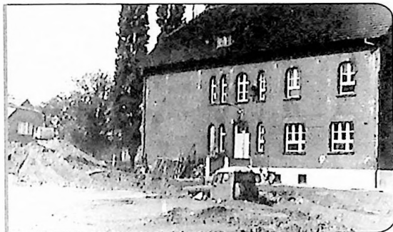
Budowa nowej szkoły rozpoczęta
