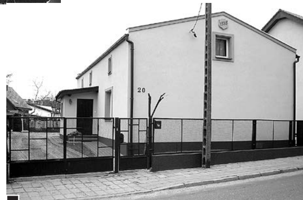
Historyczny dom Andrzeja Remleina przy ul. 3 Maja 20 wybudowany w 1898 roku, o czym świadczy tarcza herbowa z datą pod kalenicą. Budynek usytuowany charakterystycznie dla tamtych czasów – szczytem do ulicy fot. arch. „WL” Paweł Wolniewicz
