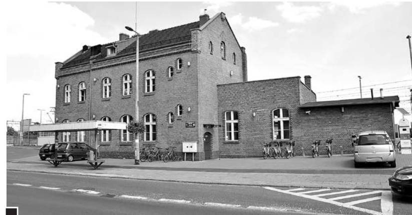
Dworzec PKP w Luboniu już od wielu lat jest siedzibą m.in. lokalnej Straży Miejskiej fot. Piotr P. Ruszkowski
