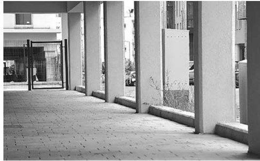
Wzdłuż bloku od strony ul. A. Mizerki pomiędzy filarami podcienia znajduje się betonowy próg na całej długości bloku. Niezależnie od przyszłego projektu drogi, jeśli nie zostanie usunięty, pozostanie barierą architektoniczną fot. Piotr P. Ruszkowski
