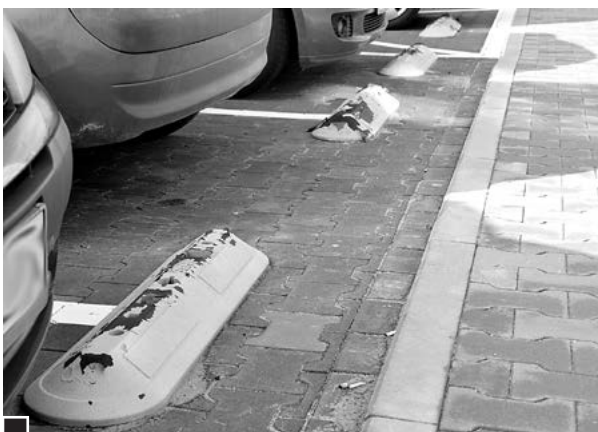
Nowe Centrum Lubonia, nie ma szczęścia do porządnym ograniczników dla kół zamontowanych na miejscach parkingowych. Na wcześniej budowanym odcinku zainstalowano miękkie, gumowe, nietrwałe. Te wydają się być solidniejsze, twardsze i większe. Za to żółta farba, jaką je pomalowano, schodzi całymi płatami bez właściwego traktowania – użytkownika niezgodnego z przeznaczeniem fot. Piotr P. Ruszkowski
