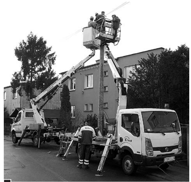
Montaż nowego, masywnego słupa fot. Paweł Wolniewicz
