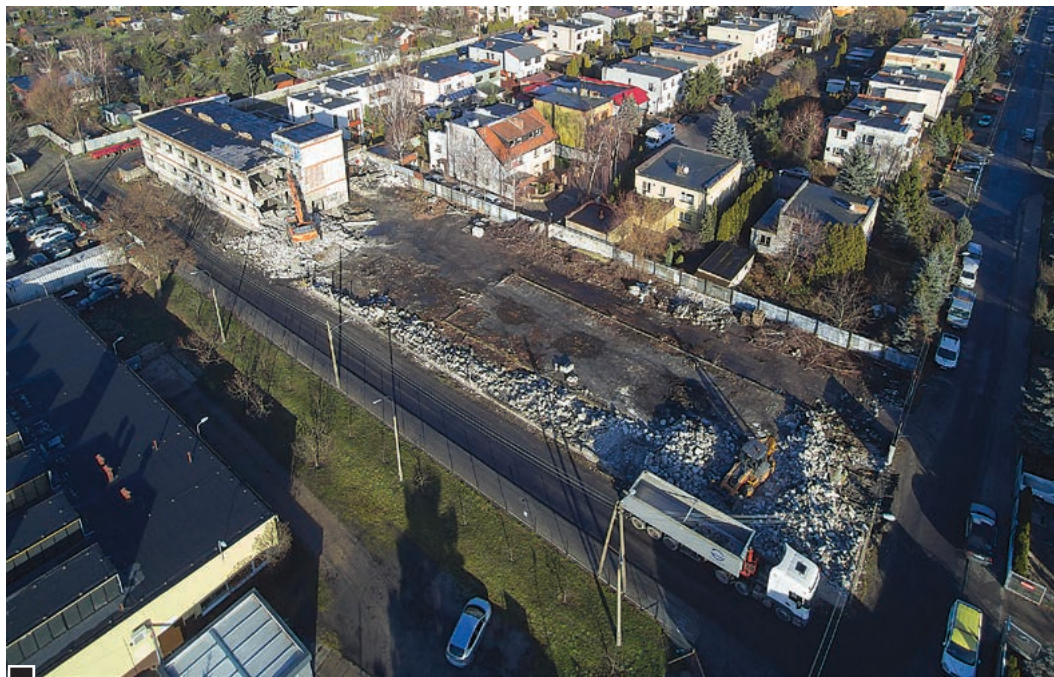
6 grudnia (mikołajki), kiedy rozpoczęto wyburzanie ruin po byłej firmie przy ul. Zielonej, można było po raz ostatni zobaczyć główny obiekt „Intersmaku” od strony ul. Granicznej (lewy, górny narożnik zdjęcia) fot. Rafał Wojtyniak
