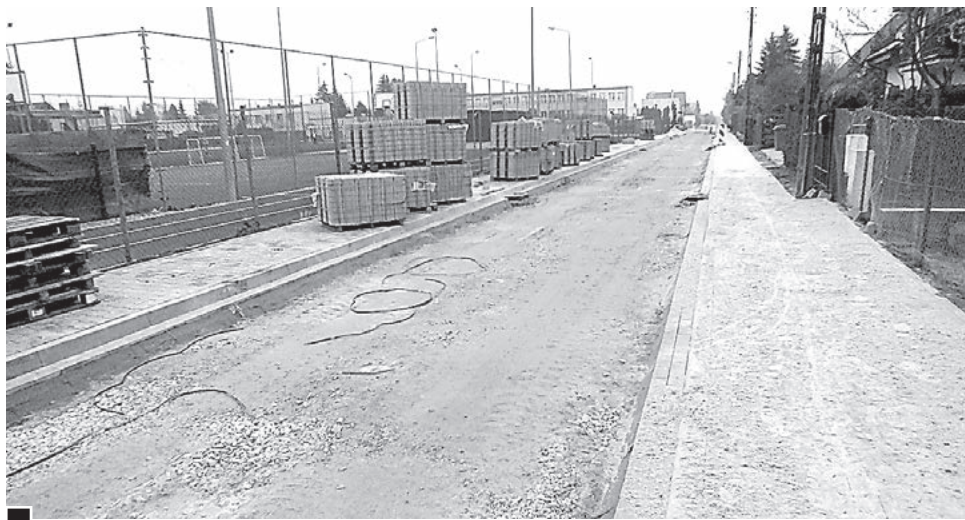
Inwestycja drogowa na ul. Dojazdowej od Sobieskiego do Rydla, przy zespole boisk i Szkole Podstawowej nr 4 fot. Hanna Siatka
