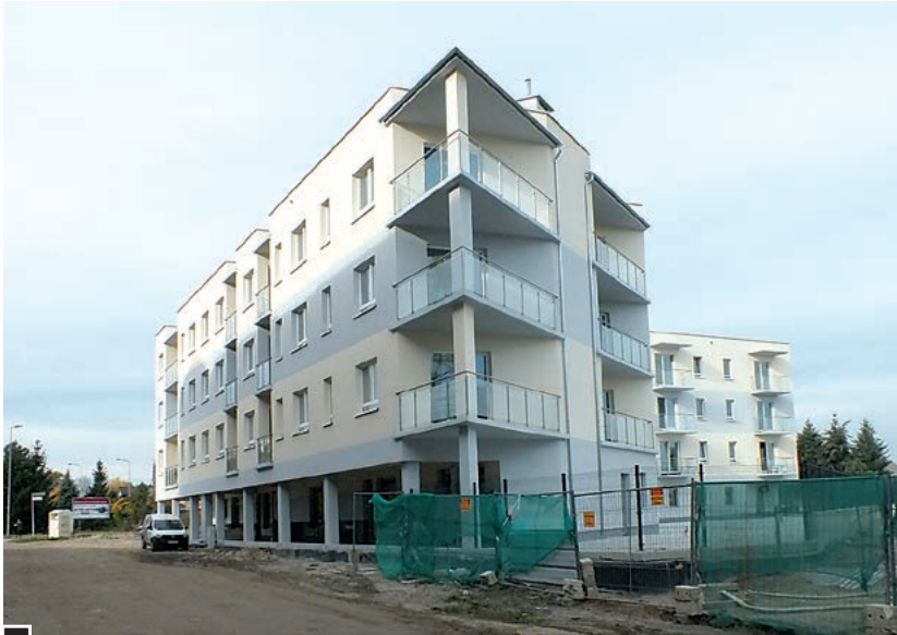
Gotowy budynek firmy „Immo-Building”, do którego wprowadzają się pierwsi mieszkańcy – widok od ul. Andrzeja Mizerki fot. Hanna Siatka
