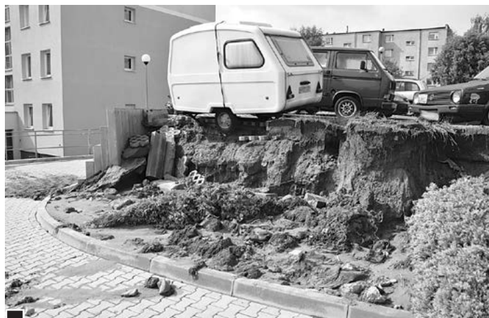
Podmyta przez wodę z zapchanej studzienki, świeżo usypana skarpa przy nowym dojeździe do ROD „Bratek” na ul. Sikorskiego (czytaj na str. 17). Tylko dzięki zablokowaniu koła przez obsuniętą płytę z parkingu, przyczepa kampingowa nie runęła. O dopiero co zakończonej inwestycji czytaj na str. 17 fot. Piotr P. Ruszkowski
