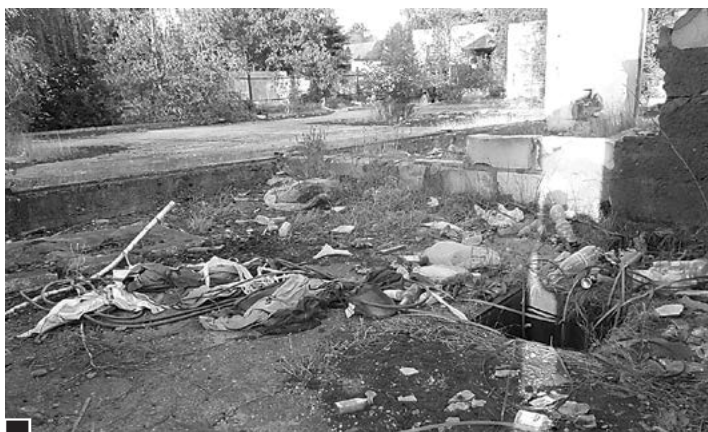
Zaśmiecony plac byłej firmy z niezabezpieczonymi studzienkami i innymi niebezpiecznymi pułapkami fot. Hanna Siatka
