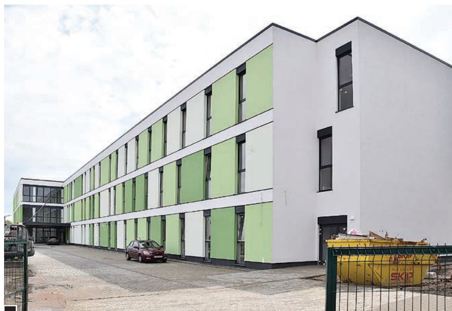
Budynek OREW EMEDEA o długości 100 m, powstały za Ośrodkiem Kultury przy ul. Sobieskiego, zostanie otwarty już we wrześniu
