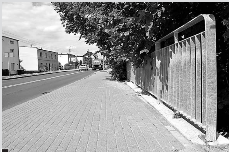
Chodnik i jednocześnie międzynarodowa trasa rowerowa na ul. Armii Poznań (drodze wojewódzkiej 430) uzbrojone w porządną barierę nad Strumieniem Junikowskim fot. Piotr P. Ruszkowski
