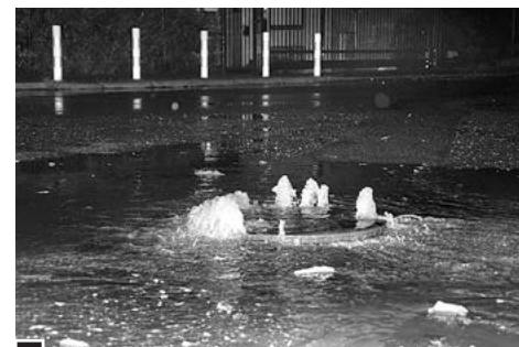
Jeszcze półtorej godziny po burzy, woda wydostająca się z kanalizacji deszczowej na ul. 3 Maja unosiła kłapy studzienki, a przez otwory pod ciśnieniem wytryskiwały fontanny fot. Piotr P. Ruszkowski
