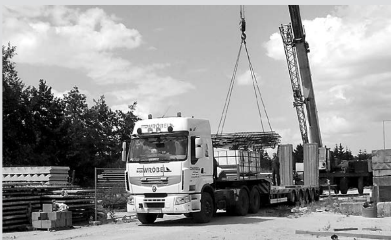
26 czerwca firma „Wróbel” wywoziła z placu budowy przy ul. Wschodniej 19 część swojego dobytku fot. Hanna Siatka
