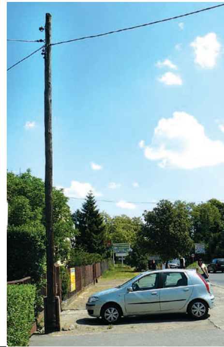
Stary, drewniany słup jest coraz bardziej krzywy. Na całej wysokości słupa są widoczne liczne pęknięcia i uszkodzenia struktury fot. Paweł Wolniewicz
