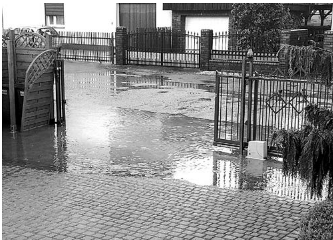
Fragment ul. Spornej, na której nieodpowiednio wyprofilowany chodnik z jezdnią powodują zalewanie posesji fot. Agnieszka Wójcik
