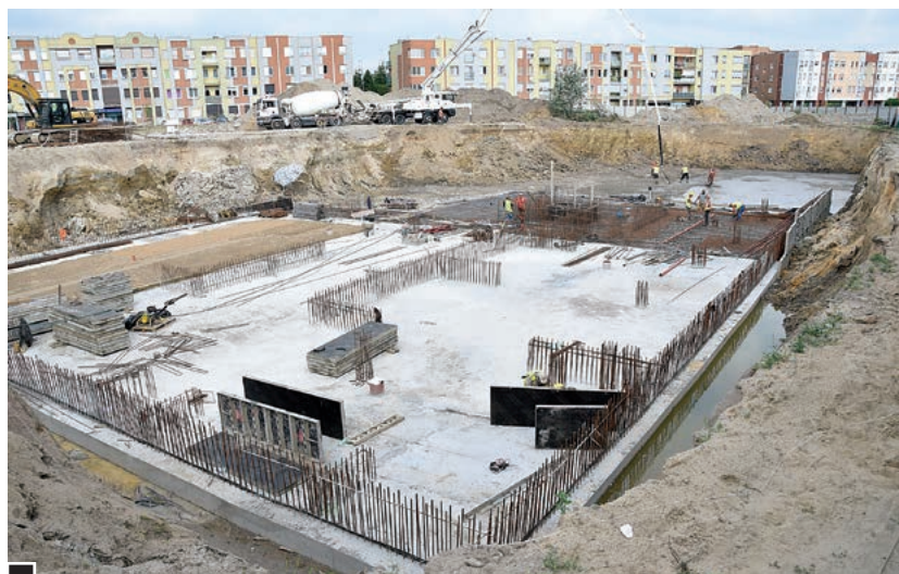
Plac budowy 2. etapu inwestycji firmy Immo Building – widok od strony ul. Mizerki, w tle bloki przy al. Jana Pawła II fot. Piotr P. Ruskowski
