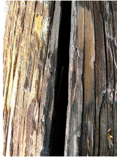
Stary, drewniany słup jest coraz bardziej krzywy. Na całej wysokości słupa są widoczne liczne pęknięcia i uszkodzenia struktury fot. Paweł Wolniewicz
