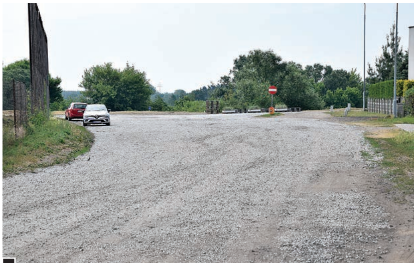
Tłuczniem wyrównana i utwardzona końcówka nie asfaltowej ul. Rzecznej (po prawej) kończąca się jedynie znakiem zakaz wjazdu, oraz parking usytuowany przy płocie boiska treningowego stadionu miejskiego (z lewej) fot. Piotr P. Ruszkowski
