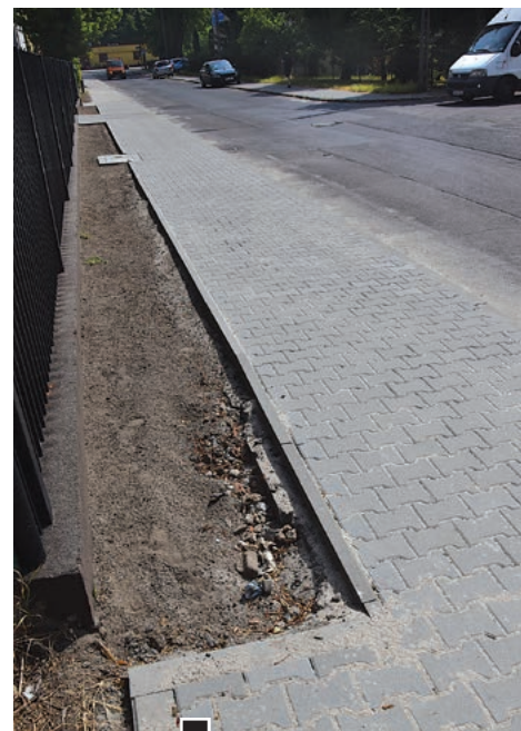
Wymieniony na brukowy, chodnik po jednej stronie ul. Kościelnej fot. Piotr P. Ruszkowski
