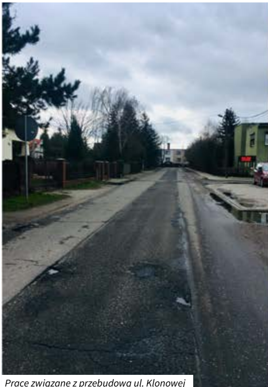
Prace związane z przebudową ul. Klonowej
