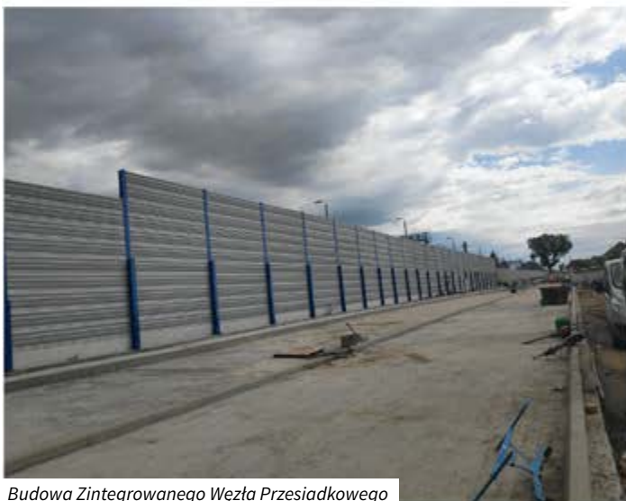
Budowa Zintegrowanego Węzła Przesiadkowego
