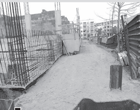
Zasypane fundamenty nieskończonego bloku przy ul. Wschodniej 19 w miejscu pokazywanym przez nas wcześniej – po stronie wschodniej fot. Hanna Siatka
