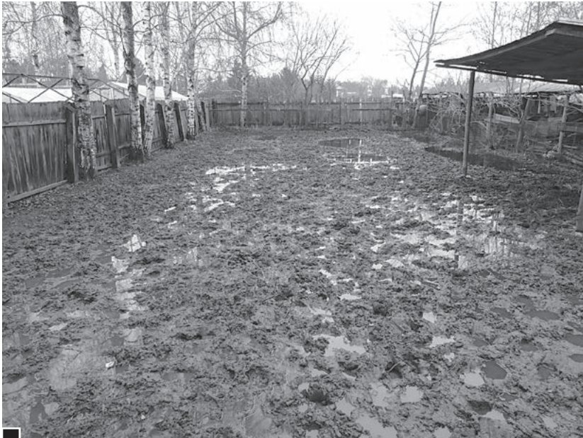
Posesja przy ul. Szymanowskiego – teren notorycznie podmokły na skutek przebranego systemu дренаży
