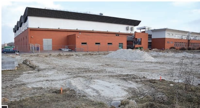
Przygotowanie terenu pod kompleks boisk przy ul. Kołłątaja 2 fot. Piotr P. Ruskowski
