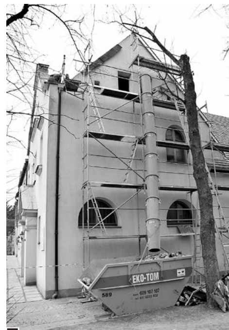
Remont dachu Sanktuarium bł. Edmunda fot. Piotr P. Ruszkowski
