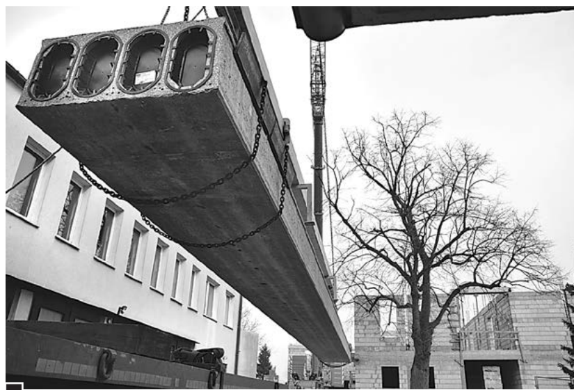
Jedna, specjalnie wzmocniona płyta stropowa do przykrycia sali gimnastycznej, nad którą będą dwa inne duże pomieszczenia, ma 17 m długości i waży 13 ton. Potrzeba było 22 takich elementów. Od 6 marca na plac budowy zwoziły je dłuższe aż z Ostrowa, gdzie produkuje je renomowana firma Consolis – największy w Europie producent prefabrykatów betonowych fot. Piotr P. Ruszkowski
