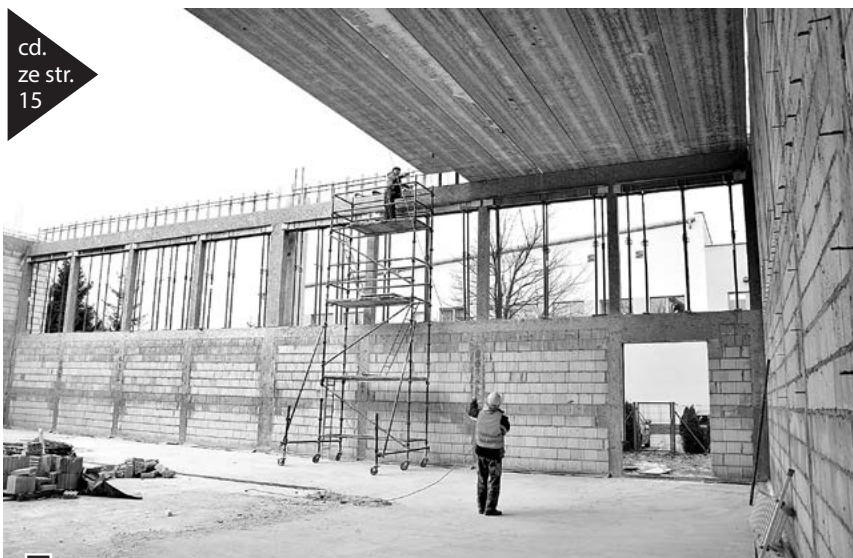
Kładzenie stropów drugiej kondygnacji na sali gimnastycznej fot. Piotr P. Ruszkowski
