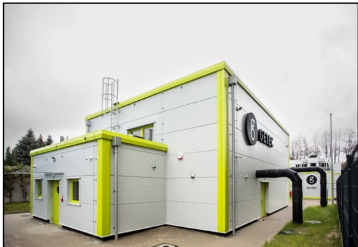
Budynek nowej elektrociepłowni działający przy ul. Źródlanej fot. Zb. GETEC
