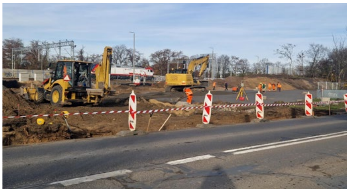
Budowa parkingu, na którym do końca 2025 roku powstaną 94 miejsca postojowe fot. Beata Spychała
