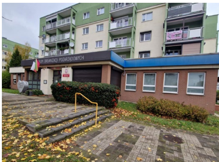
Budynek COP, w którym od stycznia urzędować będzie Straż Miejska fot. Beata Spychała
