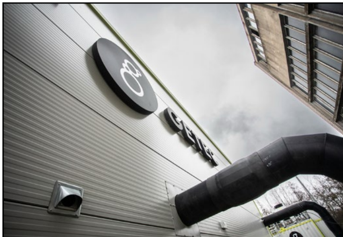
Stara i nowa ciepłownia Luboniani fot. Zb. GETEC
