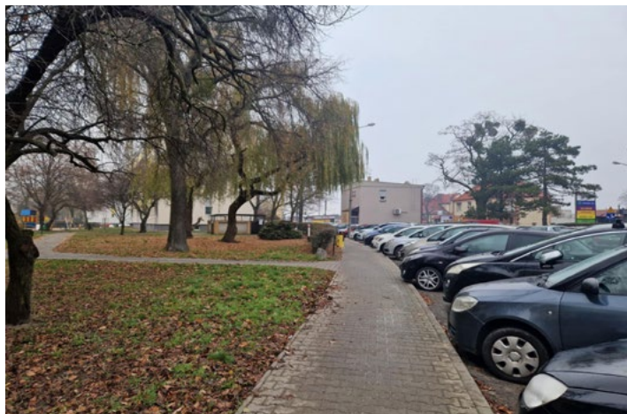
Miejsce między blokami, gdzie docelowo powstanie nowy parking fot. Beata Spychała
