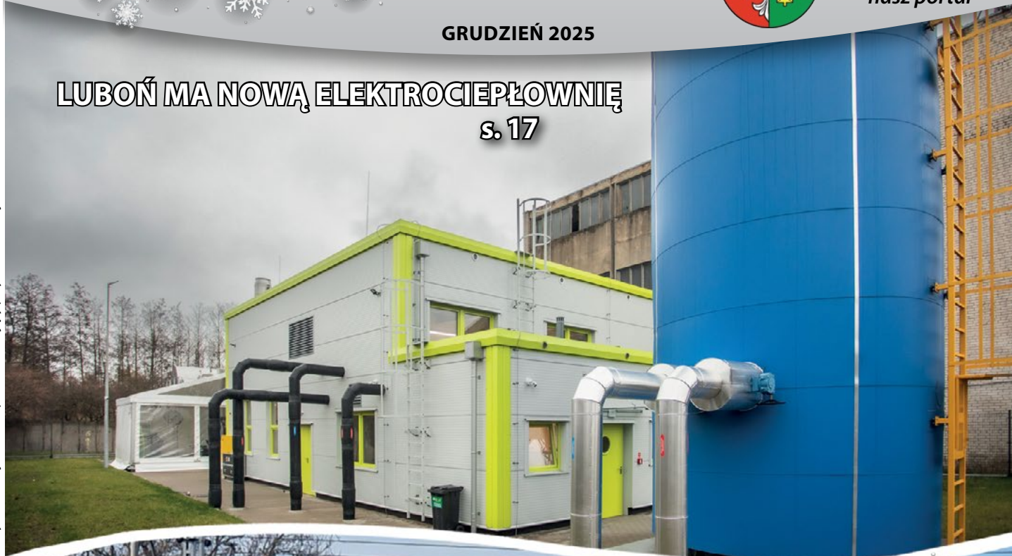
Budynek nowej elektrociepłowni działający przy ul. Źródlanej fot. Zb. GETEC
