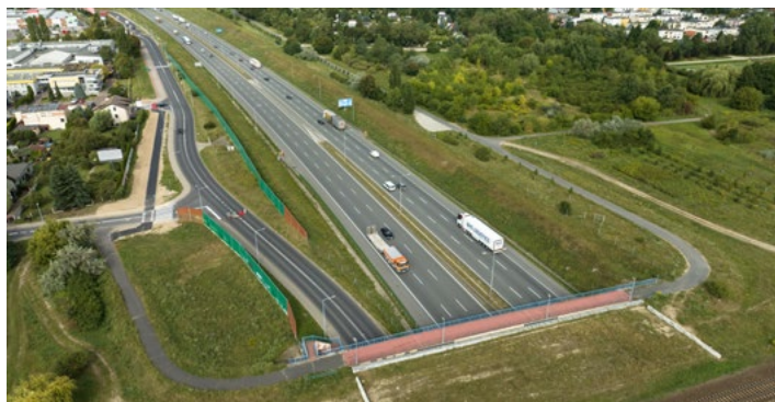
Lubońska Wartostrada zbudowana w ramach LBO fot. Rafał Wojtyniak
