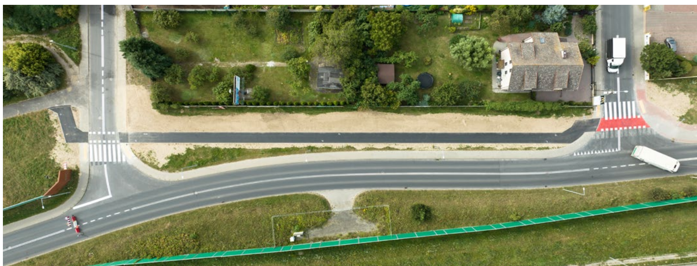
Zakończyła się budowa drogi rowerowej wzdłuż ul. Dębieckiej. Dzięki niej mieszkańcy wybierający rower mogą teraz wygodnie przemieszczać się na odcinku pomiędzy ul. Rivoliego a ul. Niepodległości fot. Rafał Wojtyniak
