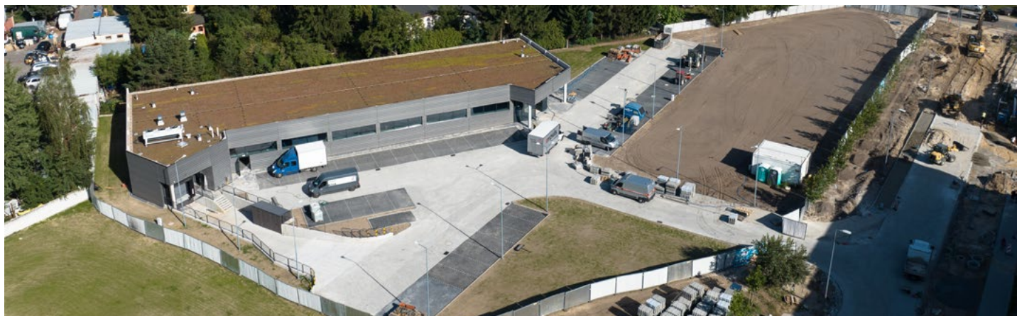
Widok z drona na plac budowy, na którym powstaje sklep Aldi w Luboniu (sierpień 2025 r.) fot. Rafał Wojtyniak
