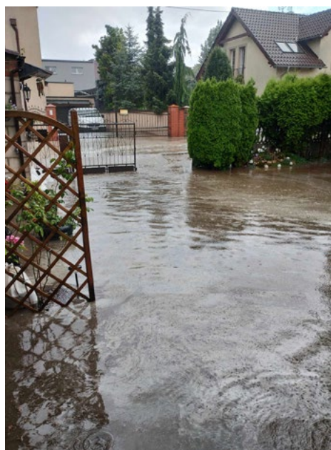
Woda deszczowa wdzierająca się na działkę przy ul. Kościuszki 42 fot. Autorka listu
