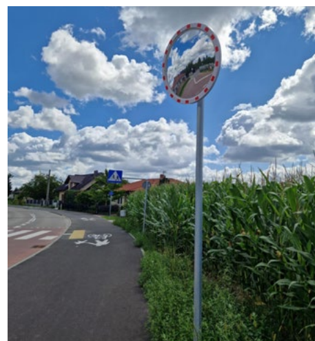
Zamontowano lustro drogowe przy skrzyżowaniu łączącym ulice Buczka i Poprzeczną fot. Beata Spychała
