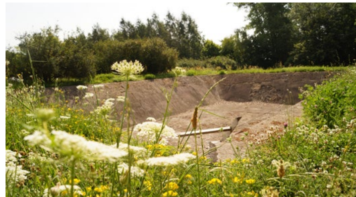
Pozostałości basenu przeciwpożarowego fot. Patrycja Hajder
