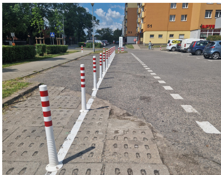
Nowe oznakowanie poziome oraz słupki wyznaczające granice działki fot. Zb. red.
