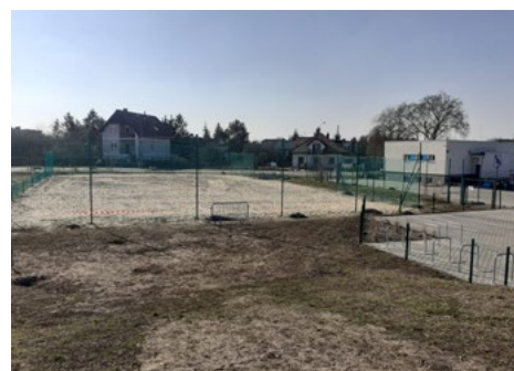
Na budowanym boisku do piłki nożnej plażowej na Stadionie Miejskim przy ulicy Rzecznej postawione zostały słupki i rozwieszona została siatka piłkochwyty fot. Zb. LOSIR
