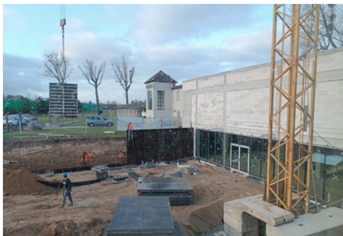
Gmach budynku znajduje się w stanie surowym, trwają prace instalacyjne oraz te polegające na jego ociepleniu fot. Zb. Muzeum Martyrologicznego w Żabikowie
