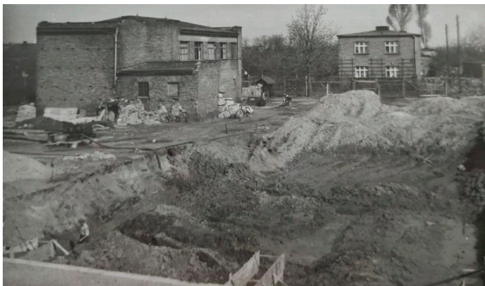
Wykop pod nową szkołę rozpoczęto we wrześniu 1963 r., po stronie lewej budynek Towarzystwa Gimnastycznego „Sokół” fot. z kroniki SP4
