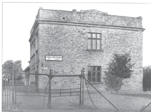
Ryc. 110. SP nr 4 – budynek III z 1931 r., za nim widoczny skraj budynku II z 1913 r. (ok. 1960 r.)
