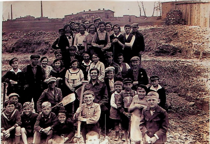
Budowa kościoła w Luboniu
