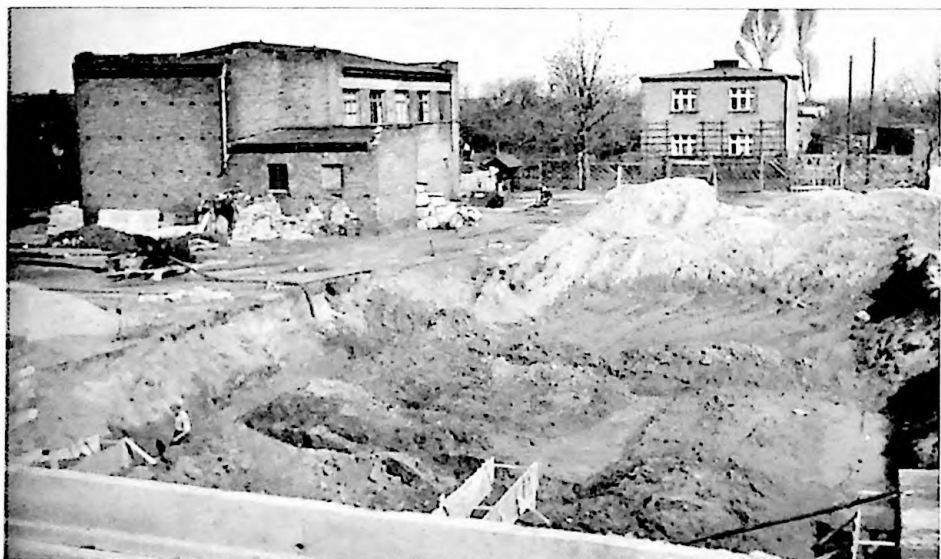
Wykop pod nową szkołę przy ulicy 1 Maja 10, rozpoczęto we wrześniu 1963 roku.
