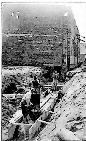
Ławy fundamentalne pod kotłownię.
