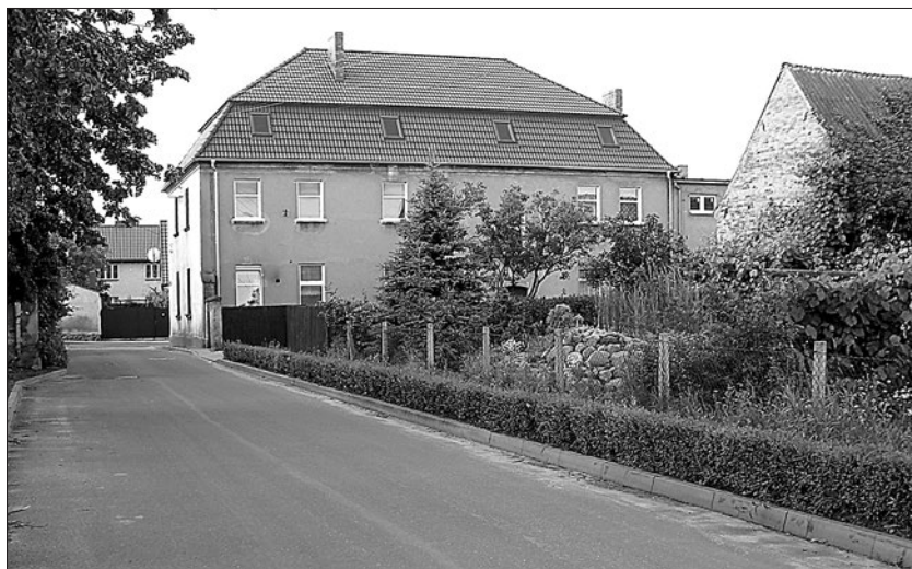
Ryc. 122. Bukowiec Górny – dawny hotel W. Śliwy, widok od podwórza (2009 r.)
