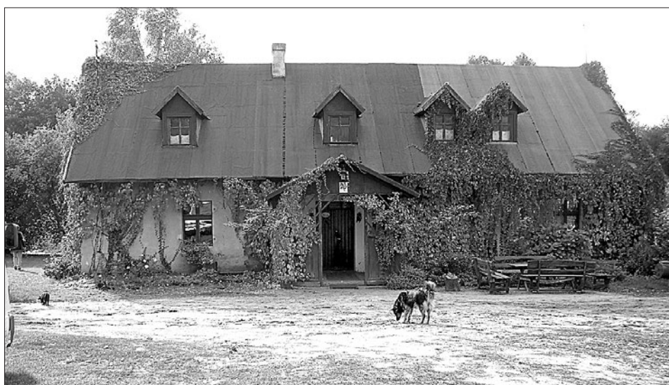
Ryc. 197. Trzebidza – budynek ośrodka, widok od północy (2009 r.)
