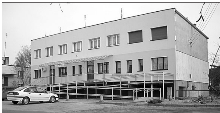
Ryc. 29. Włoszakowice – budynek ośrodka zdrowia (2010 r.)
