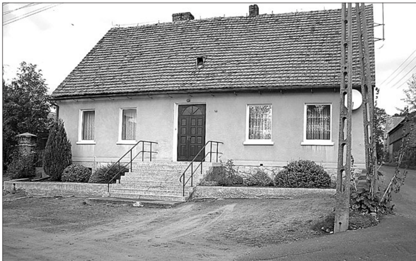
Ryc. 221. Grotniki – budynek dawnej szkoły (2009 r.)
