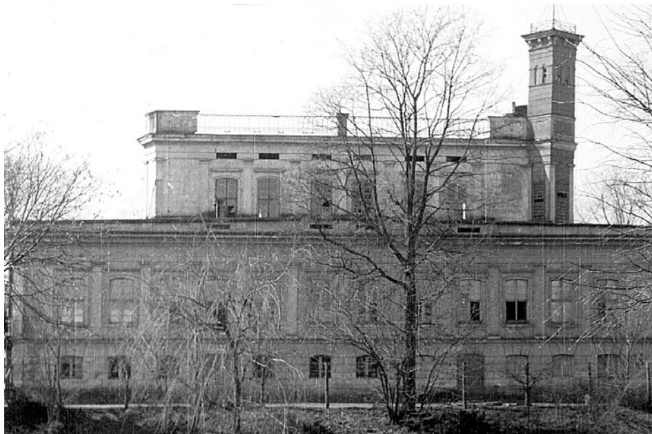
Ryc. 147. Włoszakowice – pałac z rozebraną później wieżą (widok z 1950 r.) W sierpniu 1939 r. stacjonowali tu żołnierze polscy powołani do wojska w ramach „cichej mobilizacji”.
