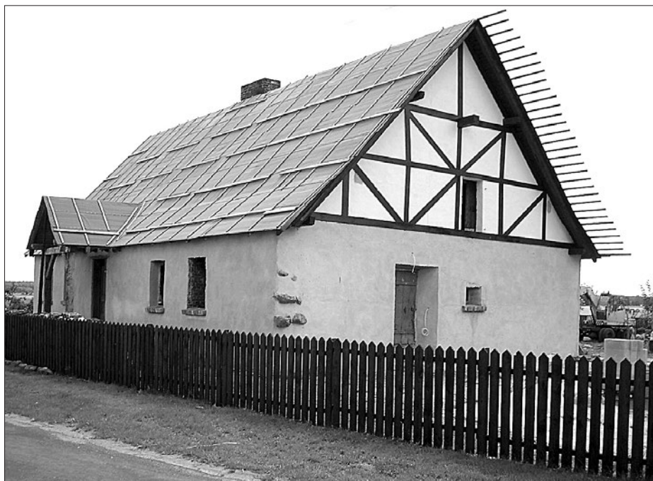
Ryc. 97. Boguszyn – dawny zajazd przy gościńcu Głogów – Poznań w przebudowie już bez stajni i wozowni istniejących w podwórzu (2009 r.)
