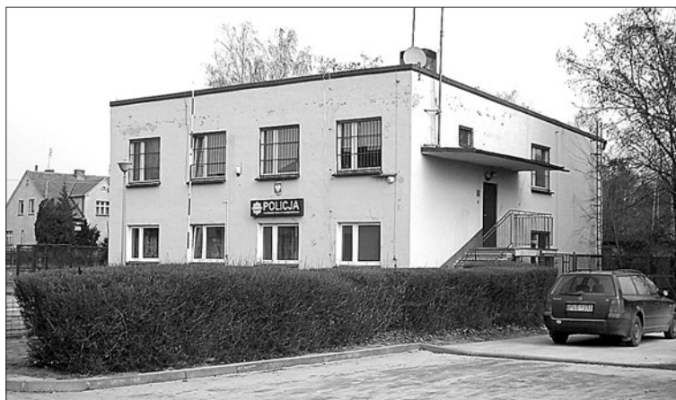
Ryc. 30. Włoszakowice – budynek policji (2010 r.)
