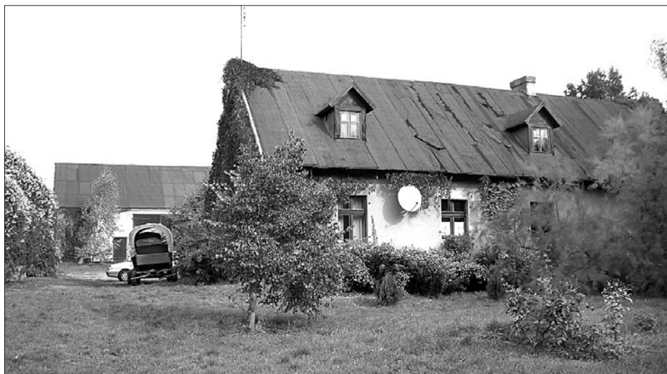
Ryc. 196. Trzebidza – zabudowania ośrodka jeździeckiego Zofii i Zdzisława Czajków, widok od południa (2009 r.)
