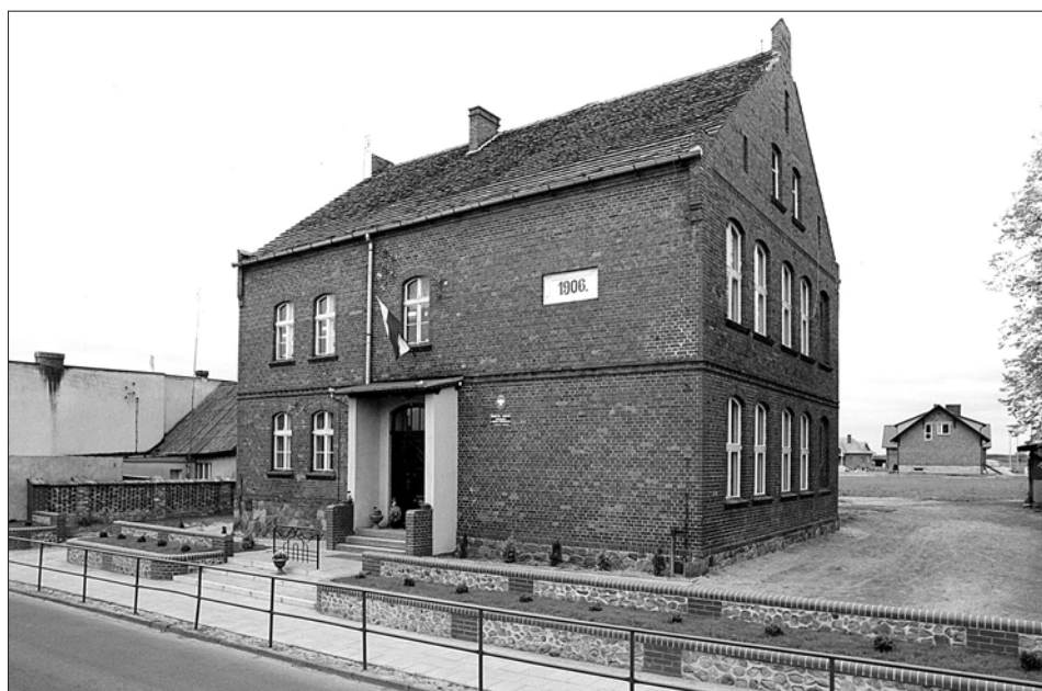
Ryc. 218. Bukowiec G. – czerwona szkoła z 1906 r. (fot. Z. Gajewski 2003 r.)
