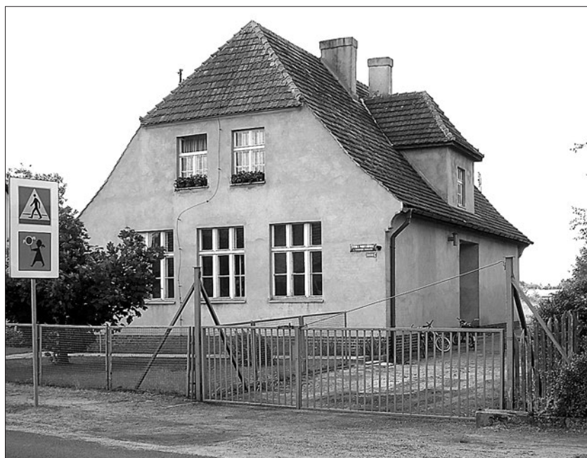
Ryc. 223. Jezierzycie Kościelne – dawny budynek szkolny z 1914 r. (2009r.)
