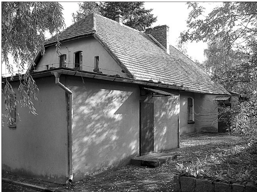
Ryc. 224. Dominice – budynek dawnej szkoły powszechnej z około 1921 r., widok od podwórza, z przodu przybudówki z lat po II wojnie (2009 r.)
