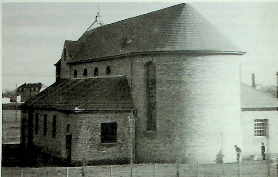
Bryła nowo budowanego kościoła pw. św. Jana Bosko w Luboniu. Wieża została wybudowana do wysokości nawy północnej i nakryta prowizorycznym dachem z desek i papy
