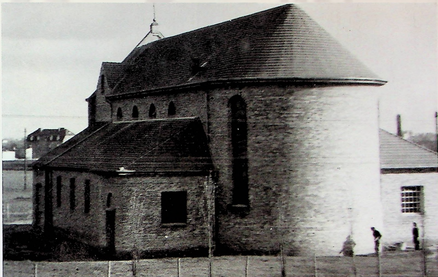
Bryła nowobudowanego kościoła pw. św. Jana Bosko w Luboniu. Wieża została dociągnięta do wysokości nawy północnej i nakryta prowizorycznym dachem z desek i papy
