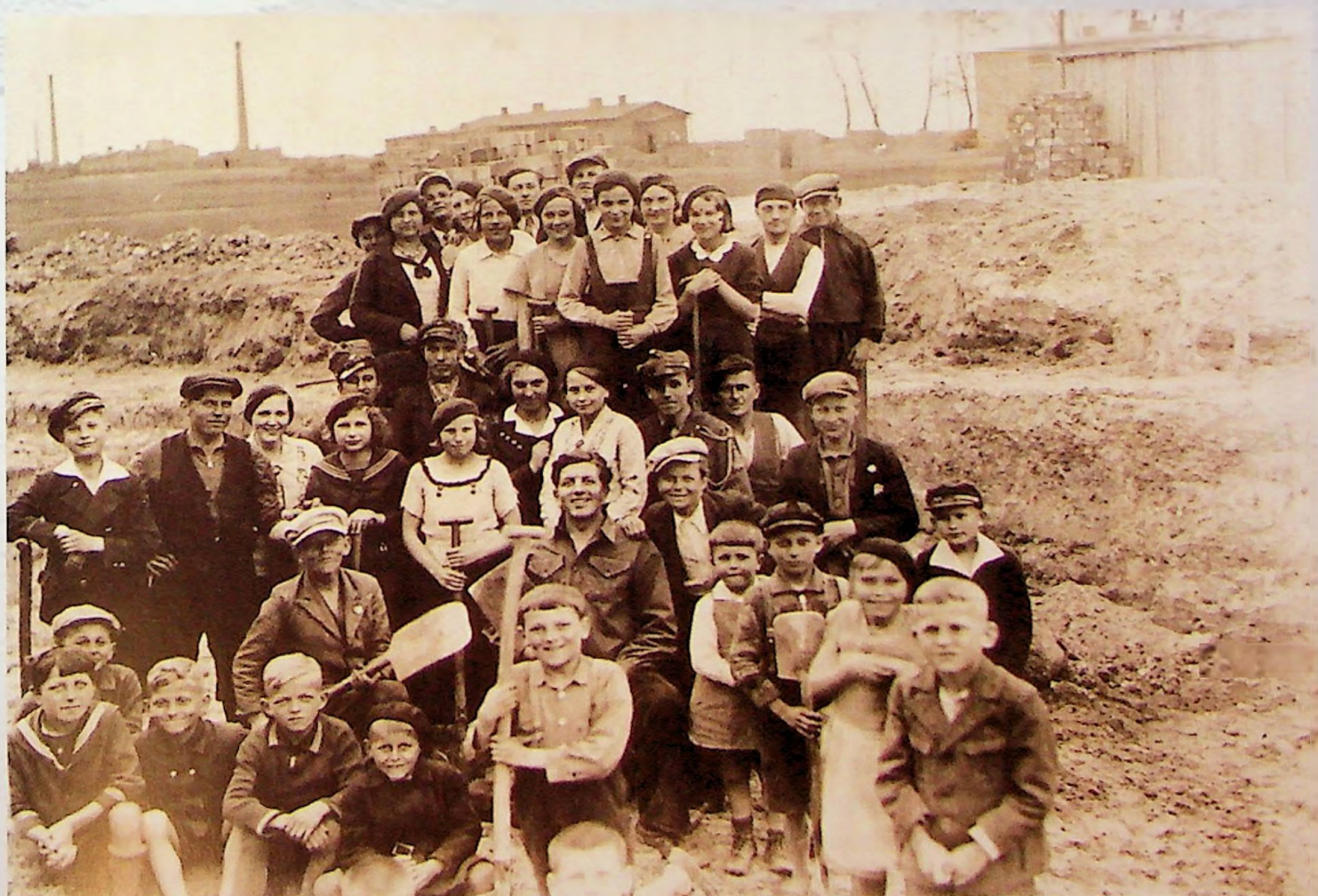
Grupa młodzieży i dzieci pracujących przy wykopach pod fundamentu kościoła pw. św. Jana Bosko, Luboń – wiosna 1936 r.
