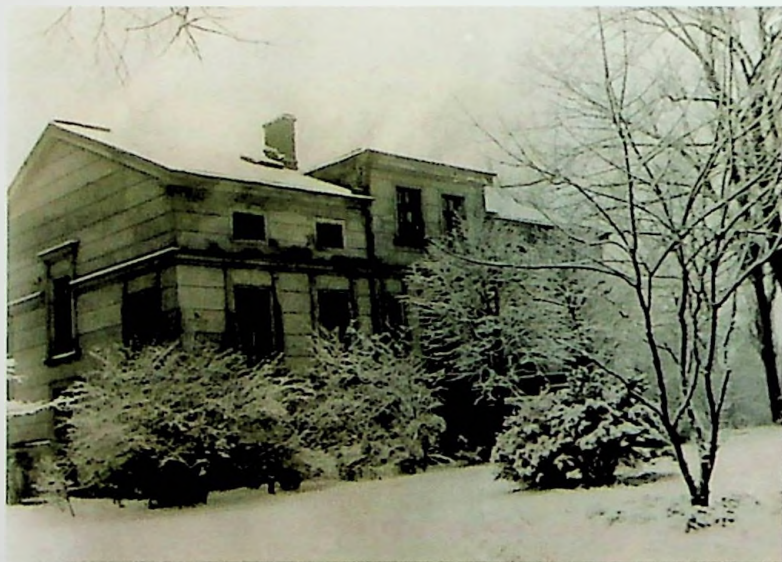
Fot. 6. Dworek przy ul. Kolejowej 29
