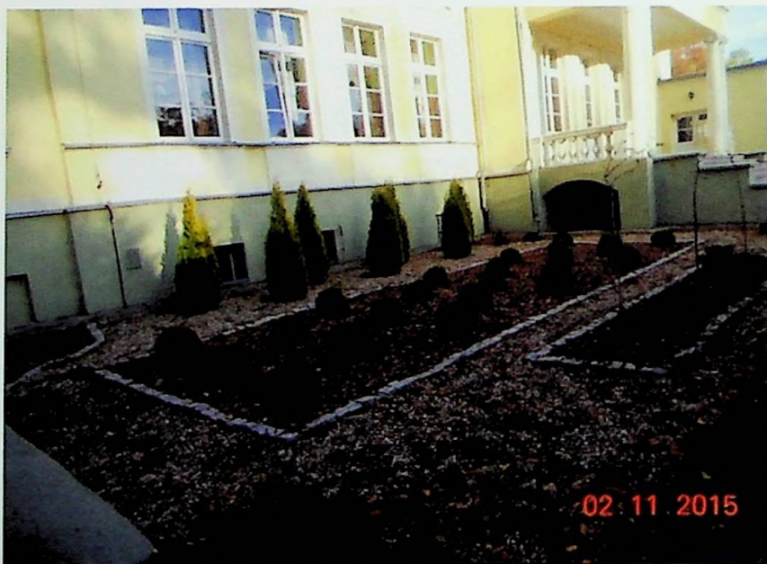
Fot. 51. Osiek – „renowacja”
