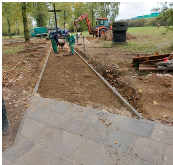
Prace na terenie Muzeum Martyrologicznego w Żabikowie fot. Zb. Zbigniewa Jurgi
