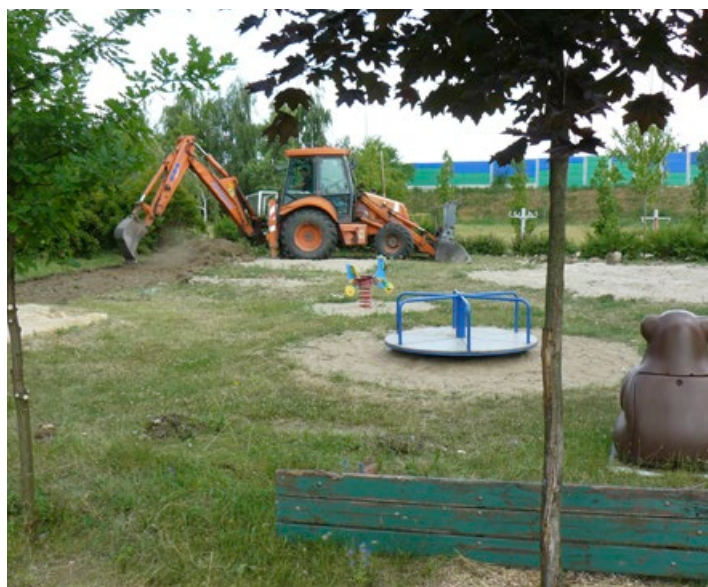
W tym roku firma modernizowała plac zabaw Autostradowa Dolinka przy ul. Chopina fot. Paweł Wolniewicz
