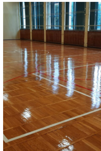
Odnowiona sala gimnastyczna w SP1 fot. Zb. SP1
