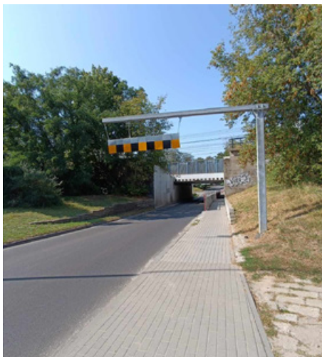
Odcinek ulicy Powstańców Wielkopolskich, od tunelu pod linią kolejową do ulicy Armii Poznań, po wykonanym remoncie fot. Sandra Kałek
