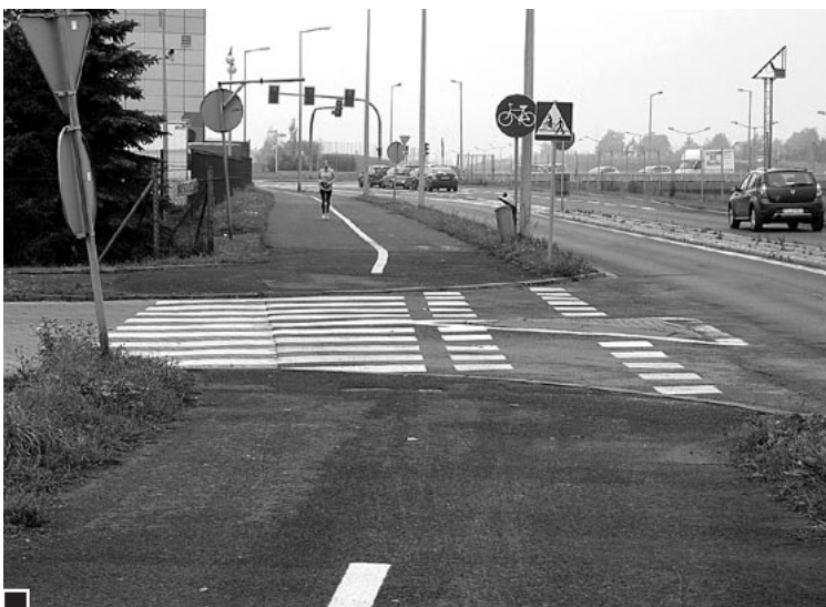
Od dawna oczekiwane przejście na ul. Unijnej na wyjeździe ze sklepu „Biedronka” fot. Rafał Wojtyniak
