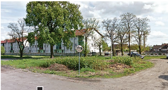
Widok skweru sprzed jego realizacji
