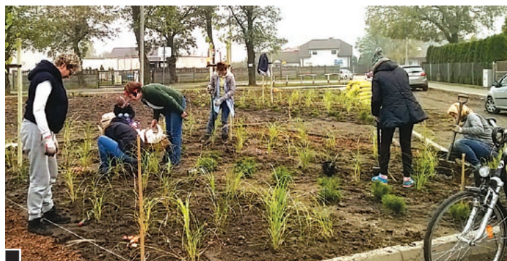
Prace przy zakładaniu skweru
