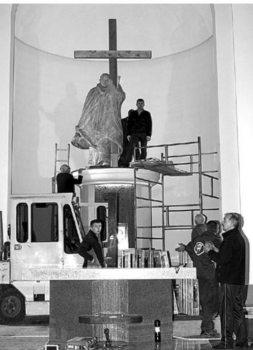
W skomplikowanej akcji montażu rzeźby w ołtarzu głównym użyto m.in. wózka widłowego, rusztowań i podnośnika
