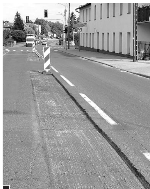
Kończy się tegoroczny remont cząstkowy nawierzchni lubońskich ulic. Na zdjęciu łatanie ul. Powstańców Wlkp. w okolicy skrzyżowania z ul. ks. Streicha i Puszkina, po prawej budynek po Szkole im. Haliny fot. Hanna Siatka
