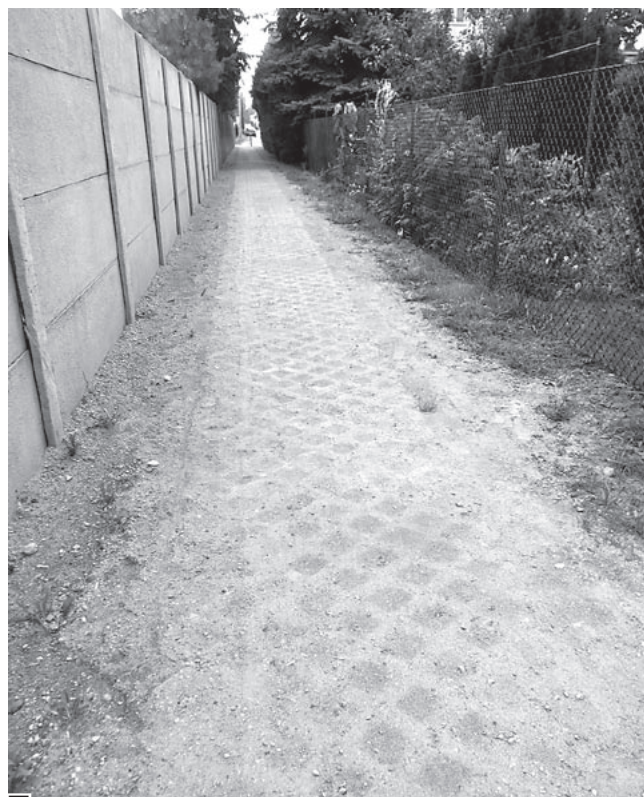
Okoliczni mieszkańcy woleliby poprzednią, gruntową nawierzchnię niż perforowane płyty z nierównościami fot. Hanna Siatka
