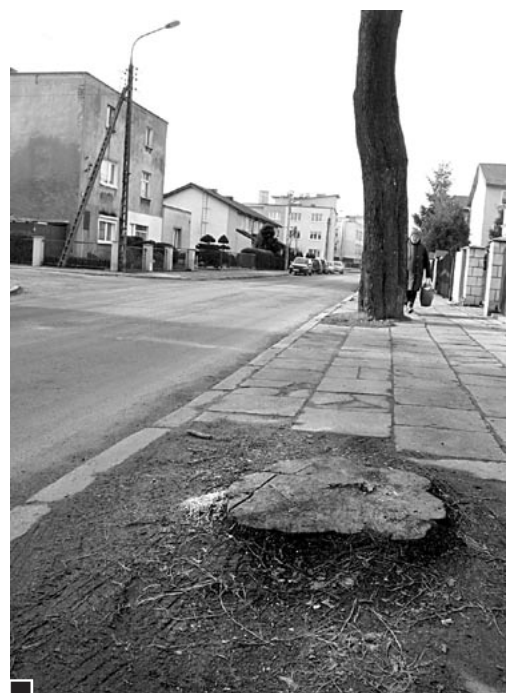
Korcz lub karpina nadal wystająca z chodnika w ul. Dąbrowskiego po ścięciu przed kilkoma laty drzewie, znajduje się zaledwie kilkadziesiąt metrów od tej wskazanej w poprzednich „Więściach”, a po interwencji prasowej sfrezowanej fot. Piotr P. Ruszkowski
