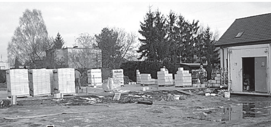
Przy ul. Wiejskiej trwają prace budowlane, wykonywane przez firmę „Pozbud T & R” SA fot. Paulina Sawicka
