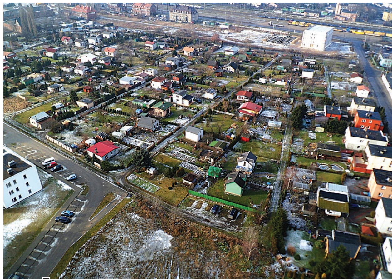
ROD „Nad Wartą” – widok obecny. Teren ogrodu ogranicza od północy (z prawej) ul. 3 Maja z budynkami mieszkalnymi, od zachodu (w głębi) ul. Żeglarska (równoległa do Armii Poznań, przed kompleksem budowanych 3 hoteli), od południa (z lewej) – niewidoczne budynki Spółdzielni Mieszkaniowej „Spójnia”, od wschodu (lewy dolny narożnik) ul. Jachtowa przy budowanym osiedlu mieszkaniowym „Warta Park”. Niektóre altany działkowe, jak widać, nie odbiegają standardem od niejednego domu fot. Rafał Wojtyński
