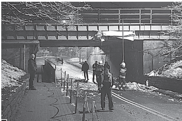
Strażacy usuwają części tira, który wjeżdżając z impetem pod wiadukt na ul. Powstańców Wlkp., został ścięty przez stalowe trażarże fot. Rafał Wojtyniak
