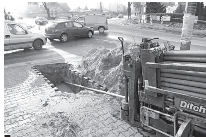
Wykonywanie bezkolizyjnego przecisku dla kabla energetycznego pod wylotem ul. Wschodniej w Żabikowską w dniu 3 lutego fot. Piotr P. Ruszkowski
