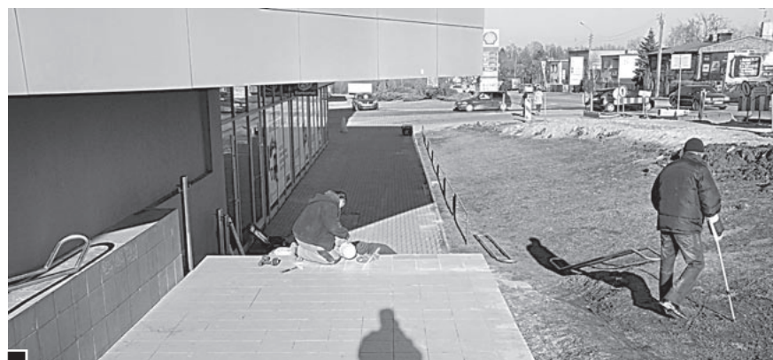
Moment montażu poręczy na środku zejścia w kierunku Pajo i przykład konieczności obejścia schodów przez osobę niesprawną po śliskim i grząskim terenie fot. Piotr P. Ruszkowski
