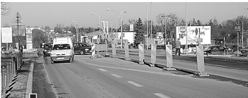
Bezsensownie ustawione pacholki na jezdni ul. Żabikowskiej, odgradzające lewoskręt w ul. Źródlaną. I tak można w nią skręcić, tyle że dalej i trudniej fot. Piotr P. Ruszkowski
