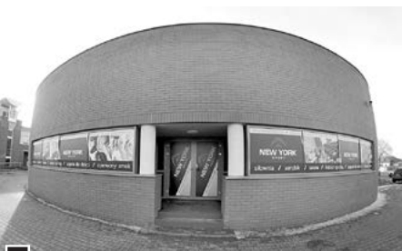
Owal hali widowiskowo-sportowej przy ul. Kołłątaja 2, za który zapłaciliśmy 45 tys. zł kary za używanie bez uzyskania decyzji o pozwoleniu na użytkowanie
