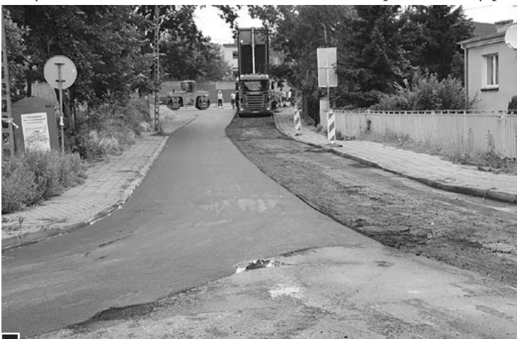
Kompleksowy remont sporego odcinka nawierzchni w ul. 3 Maja, od ul. Armii Poznań do ul. Lemańskiego fot. Piotr P. Ruszkowski
