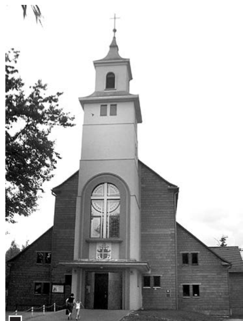
Kościół pw. św. Jana Pawła II z wieżą, w której nad głównym wejściem znajduje się witraż z rozetą pokazaną w ub. miesiącu fot. Jan Błaszczak
