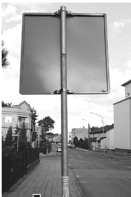
Dospawano rurę i podniesiono znak informujący o przejściu dla pieszych przy SP3 fot. Piotr P. Ruskowski
