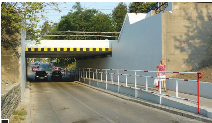
Wiadukt odnowiono, pozostawiając niezmienione od ponad 100 lat parametry fot. Paweł Wolniewicz
