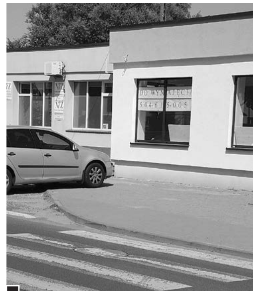
Inwestycję zakończono tuż przed przejściem dla pieszych, gdzie krawężnik nie jest przystosowany dla osób niepełnosprawnych fot. Piotr P. Ruskowski
