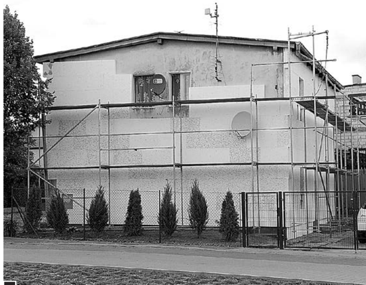
Ocieplanie styropianem domu komunalnego przy ul. 3 Maja 29. Tego zadania nie ma w oficjalnym wykazie inwestycji, przesłanym bezpośrednio z Urzędu Miasta fot. Piotr P. Ruszkowski
