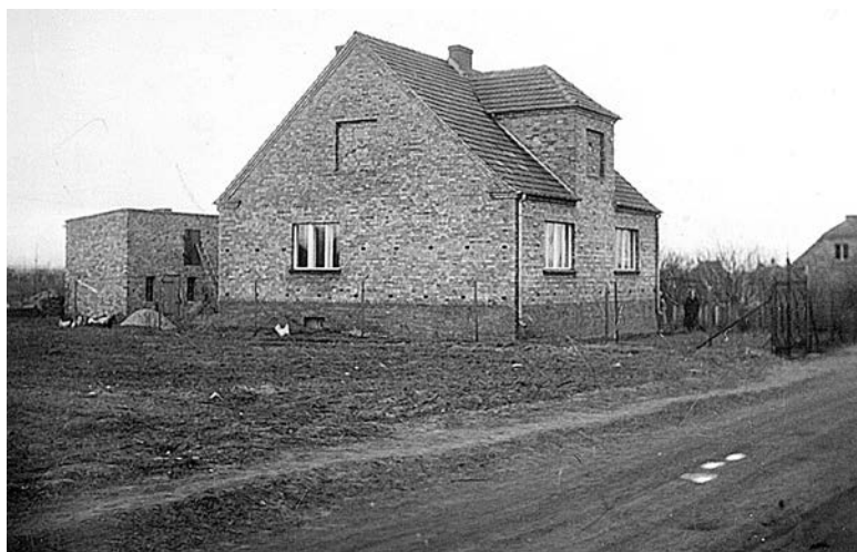
Dom wybudowany przez Stefana Czarneckiego w Luboniu przy ul. Pułaskiego 15 – dziś stacja Pogotowia ratunkowego
