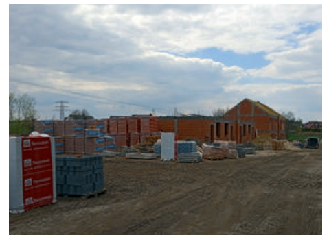
Trwa budowa sześciu budynków mieszkalnych jednorodzinnych dwulokalowych w zabudowie bliźniaczej przy ul. Sobieskiego, inwestorem jest firma BAKOS Sp. z o.o. fot. Jakub Korytowski
