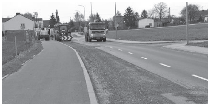
W trakcie budowy sieci kanalizacji sanitarnej i wodociągowej w ulicy Polnej fot. Paweł Wolniewicz
