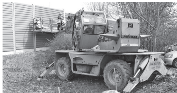
Remont i wzmacnianie ekranu akustycznego wzdłuż ul. Dębickiej, na wysokości ul. Chopina fot. Paweł Wolniewicz
