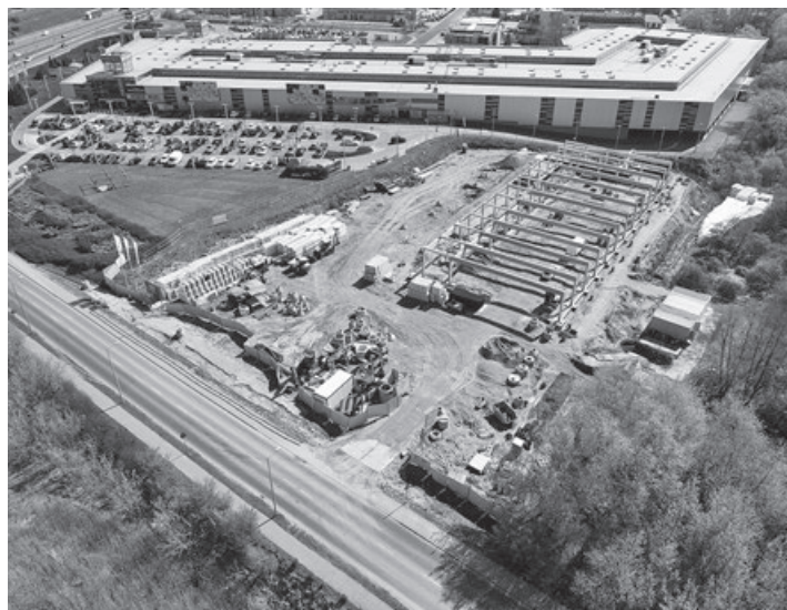
Plac budowy z lotu ptaka fot. Rafał Wojtyński
