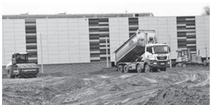
Na placu budowy pojawił się sprzęt ciężki fot. Paweł Wolniewicz
