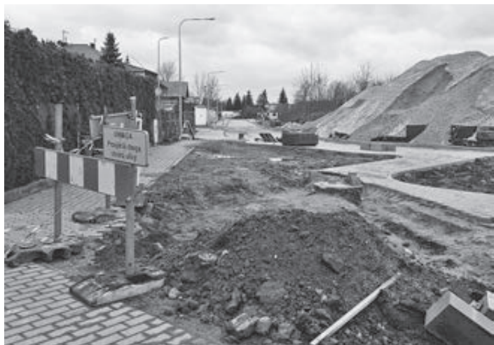
Stan prac drogowych wykonanych do dnia 30 stycznia br. przy ul. Długiej, po kilku miesiącach od ich rozpoczęcia fot. red.
