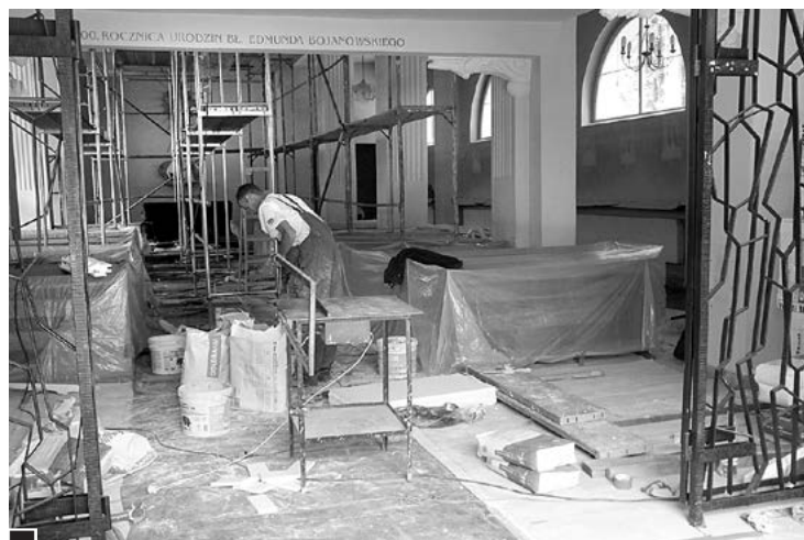
Prace remontowe w Sanktuarium bł. Edmunda Bojanowskiego fot. Hanna Siatka
