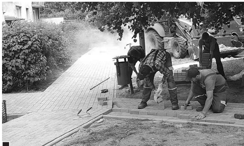
Wymiana chodnika pomiędzy blokiem przy ul. Żabikowskiej 56 i Biblioteką Miejską fot. Hanna Siatka
