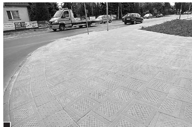
W maju zbudowano z płytek nowy chodnik na łuku ul. Żabińskiej i 11 Listopada (przy Netto). Przy przejściu dla pieszych przedostatni rząd stanowią złote płytki z wypustkami – oznaczenie dla niewidomych przechodniów fot. Hanna Siatka
