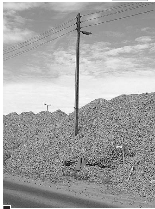
W niektórych miejscach pod tłuczniem zniknęło ogrodzenie mające zabezpieczać jezdnię. Rozrzucony tłuczeń widać też na jezdni. Pod zgromadzonymi kamieniami znika powoli również ostrzegawczy znak drogowy. Słupy tracą pion, co powoduje naprężenie lub rozluźnienie kabli energetycznych fot. Paweł Wolniewicz
