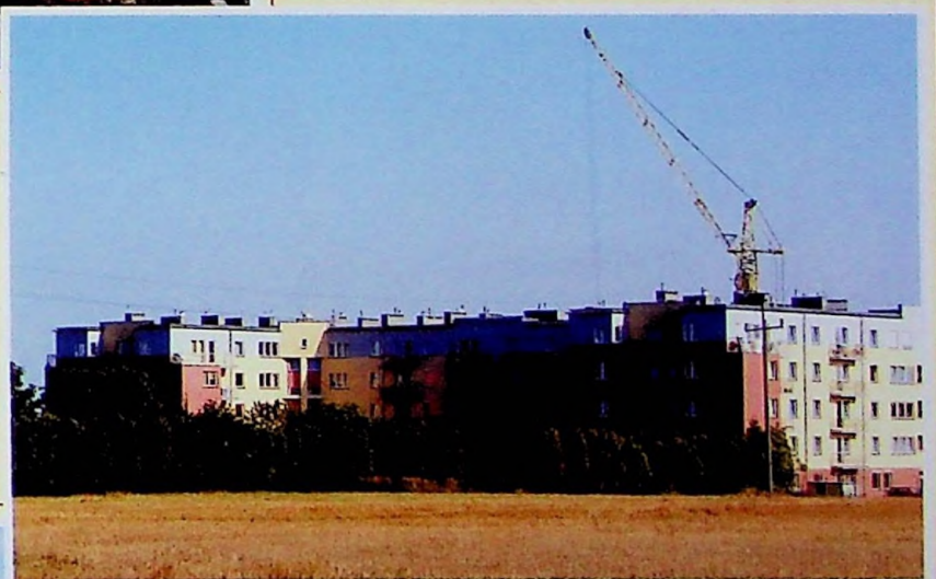
Fragment budowanego „Centrum Lubonia”.
