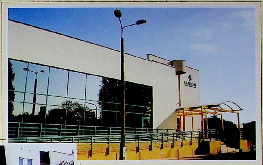
Budynek administracyjny Zakładów Chemicznych.
