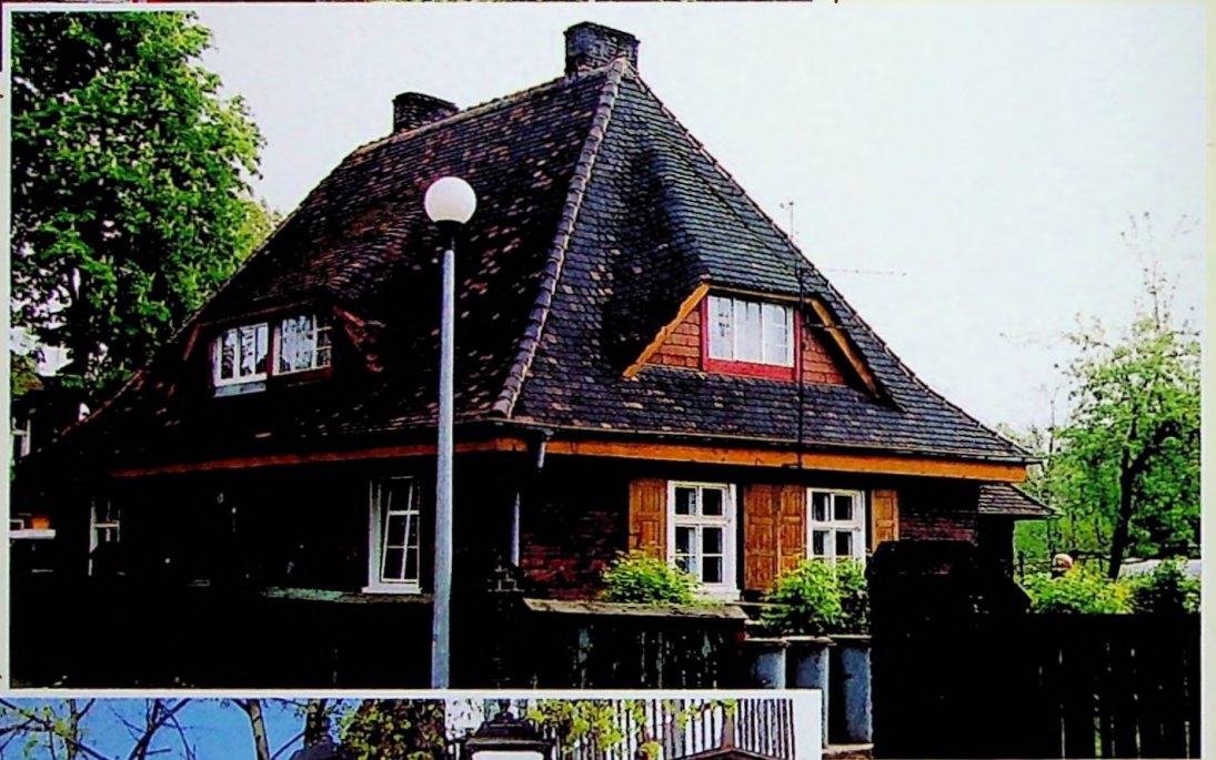
Robotniczy budynek mieszkalny powstały w 1912 r. w trakcie budowy Zakładów Chemicznych.
