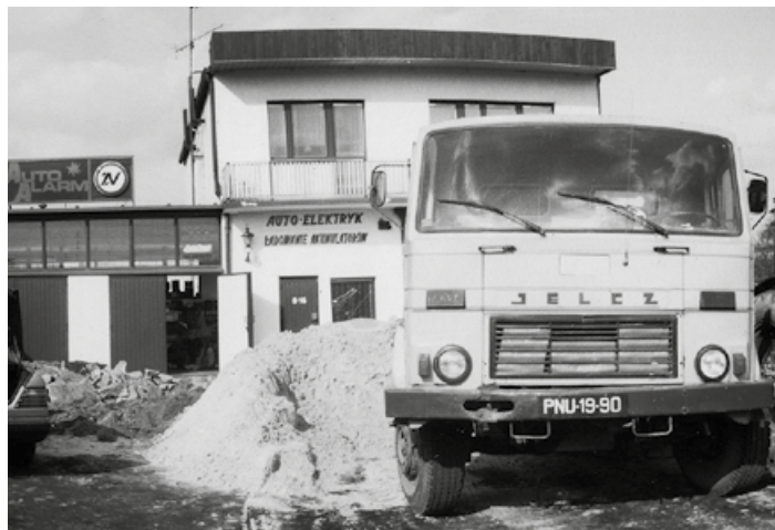
Początki firmy rok 1981, prace budowlane przy warsztacie na ul. Powstańców Wlkp. 4a fot. Zb. firmy
