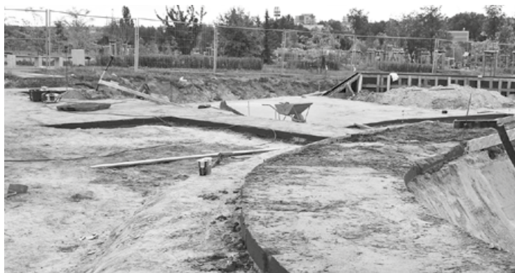
W pierwszym etapie inwestycja obejmuje budowę obiektów małej architektury w skateparku wraz z oświetleniem fot. Paweł Wolniewicz
