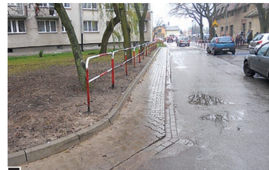
Przesunięto krawężnik i barierki, a kostką brukową poszerzono jezdnię fot. Władysław Szczepaniak
