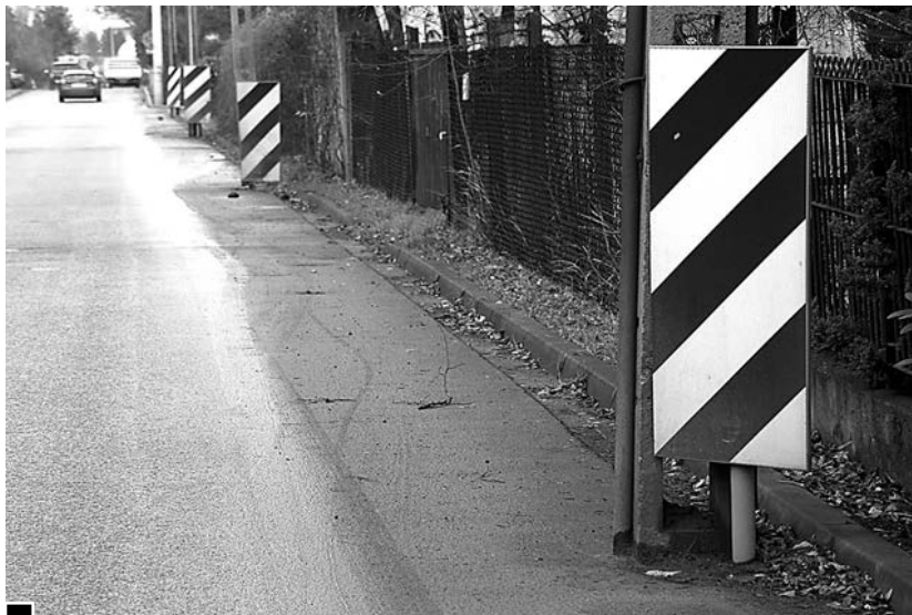
Po śladach samochodów na asfalcie ul. Traugutta widać, jak nieprzesunięte słupy energetyczne zwążają pas jezdni fot. Piotr P. Ruszkowski
