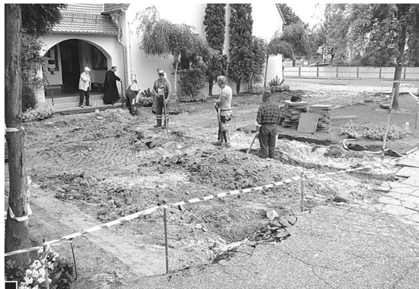
Początek prac przy przebudowie placu przed kościołem św. Barbary. „Pańskie oko konia tuczy” – ks. proboszcz systematycznie dogląda stan prac fot. Hanna Siatka
