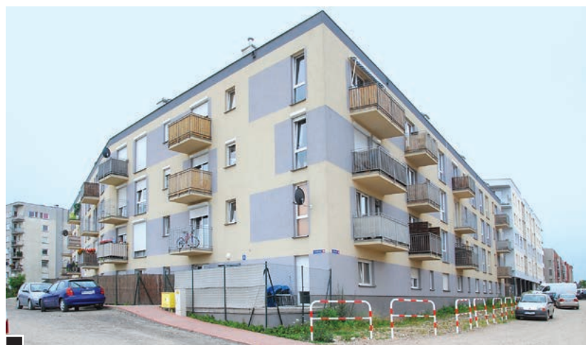
Budynek przy ul. Wschodniej 28 znajdujący się aktualnie na krańcu osiedla. Z zewnątrz prezentuje się ładnie... fot. Piotr P. Ruzzkowski
