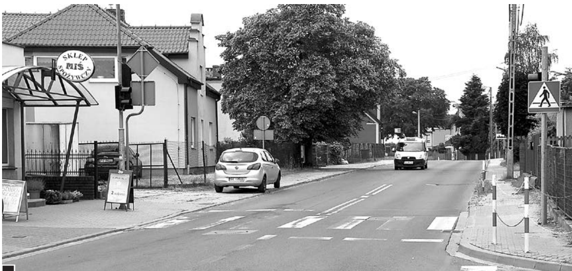
■ Niezrealizowana obietnica - kilkudziesięciometrowy fragment obustronnego chodnika na ul. Krętej i Laskowskiej, który miał być wykonany w ramach budowy obwodnicy Poznańska Polna Kręta fot. Piotr P. Ruszkowski
