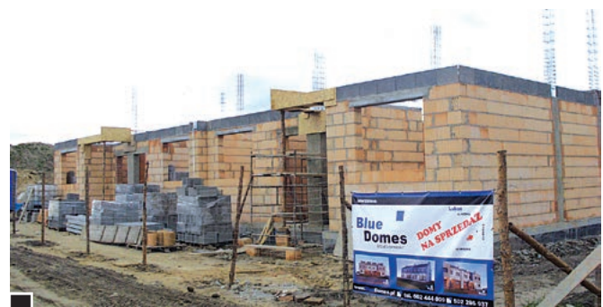
Prążące się ku górze mury budynków przy ul. Rydla – fot. Natalia
