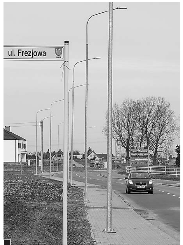
Rząd zamontowanych wiosną latarni ulicznych w części ul. Polnej. Wyraźnie widać jak dodana infrastruktura rozmiąga się z istniejącą linią chodnika. Na pierwszym planie najbardziej wysunięta w ciąg chodnika latarnia w pobliżu ul. Frezjowej fot. Piotr P. Ruszkowski
