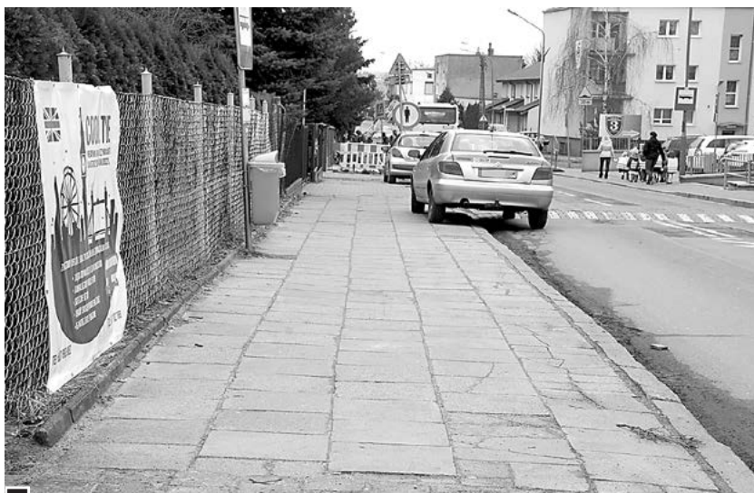
Czy ten chodnik był na tyle zdezastrowany, że najpilniej wymagał wymiany? Szeroki, w miarę gładki, żadnych pułapek, kałuż czy dziur. Zdjęcie wykonane w marcu, w „przeddzień” rozbiórki. W oddali trwa już remont od strony ul. Lemańskiego fot. Piotr P. Ruszkowski
