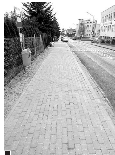
Ten sam fragment chodnika po wymianie nawierzchni na brukową. Jak na ironię, właśnie tam, gdzie znajduje się przystanek autobusowy, jego szerokość zwężono o około 0,5 m. Sam przystanek jest teraz w „pasie zieleni” (póki co, zupełnie niezagospodarowanej). Plusem dokonanej inwestycji jest wymiana krawężników, naprawa rynsztoku oraz przyległego asfaltu na jezdni. Szkoda tylko, że nie zadbanano o normatywną wysokość krawężnika na samym przystanku fot. Piotr P. Ruszkowski
