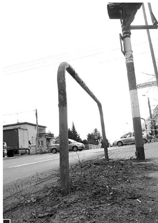
Zapomniana barierka przed sygnalizatorem przejścia dla pieszych na ul. Powstańców Wlkp. Sygnał ten też można zaliczyć do działu estetyki miasta fot. Piotr P. Ruszkowski
