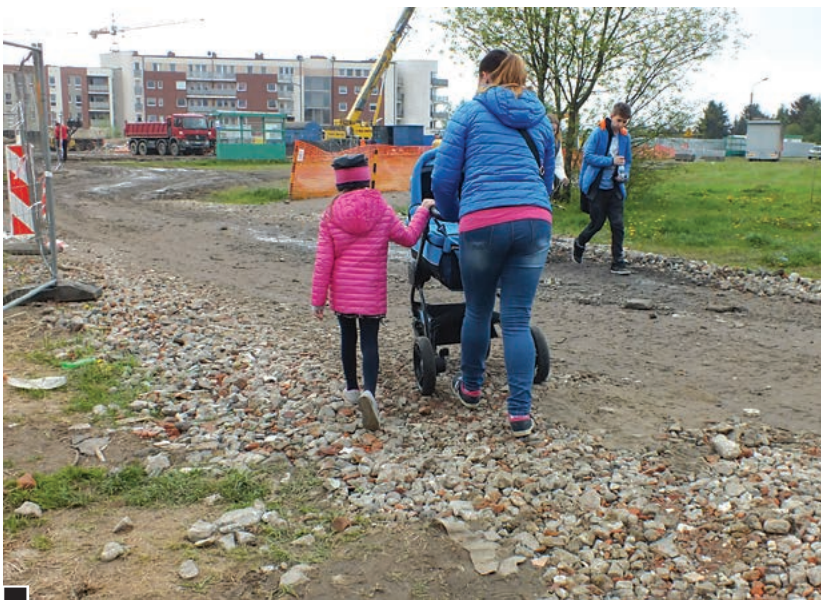
Choć fragmentarycznie przygotowano specjalne przejścia dla pieszych w okolicach placu budowy, okoliczni mieszkańcy skarżą się na uciążliwości związane z błotem, gruzem i wodą fot. Hanna Siatka
