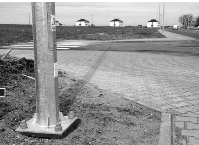
Rząd zamontowanych wiosną latarni ulicznych w części ul. Polnej. Wyraźnie widać jak dodana infrastruktura rozmiąga się z istniejącą linią chodnika. Na pierwszym planie najbardziej wysunięta w ciąg chodnika latarnia w pobliżu ul. Frezjowej fot. Piotr P. Ruszkowski
