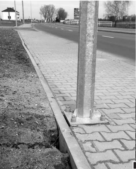
Kilka przykładów jakże różnego posadowienia latarni w stosunku do istniejącej linii chodnika. Czy to są unijne standardy? fot. Piotr P. Ruszkowski
