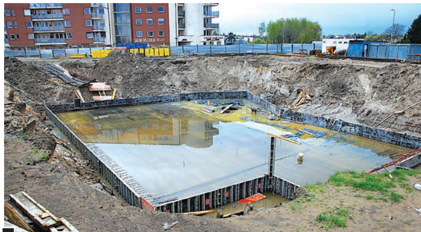
Na narożniku ul. Pułaskiego i Kochanowskiego powstał głęboki wykop i zarys budynku. Pod zgromadzonymi wodami gruntowymi widać ułożone już zbrojenie płyty fundamentowej podziemnych garaży fot. Piotr P. Ruskowski
