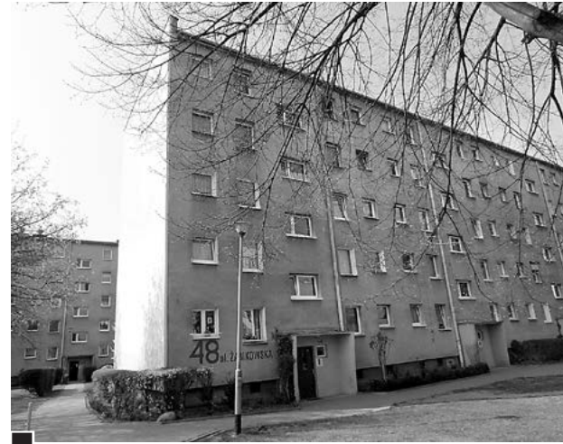
Do połowy mieszkań w bloku przy ul. Żabikowskiej 48 odcięto dopływ gazu z uwagi na nieodpowiedni system wentylacji fot. Hanna Siatka
