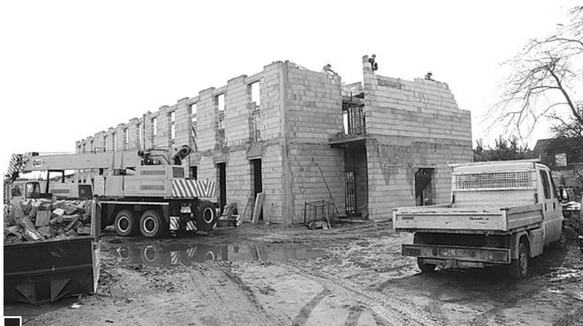
Widać już mury drugiej kondygnacji ośrodka rehabilitacyjnego, który docelowo będzie miał jeszcze jedno piętro fot. Piotr P. Ruskowski
